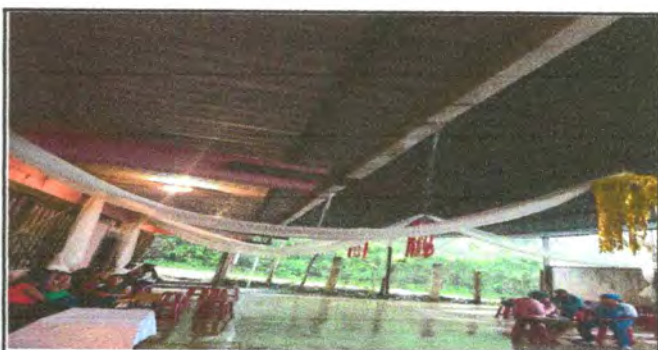
Foto 6: Reparación de canales
