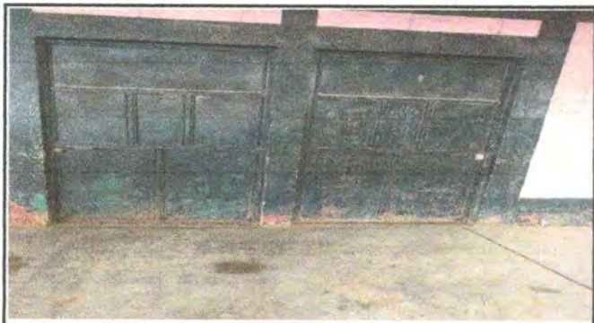
Foto 3: Reparación de Puertas
