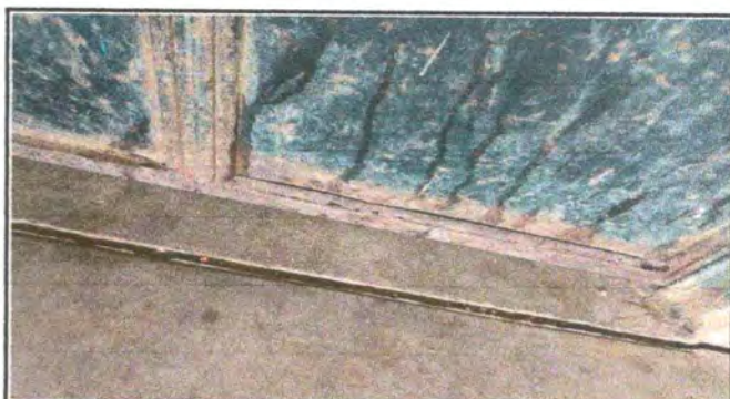
Foto 4: Reparación de puertas
