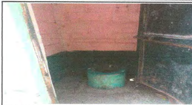
Foto 2: Reparación de baños
