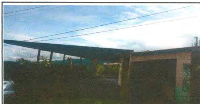
Foto 6: Reparación de estructura de techo
