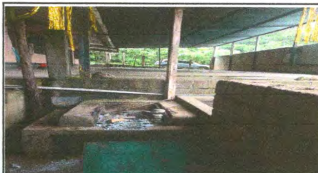
Foto 4: Reparación de cocina
