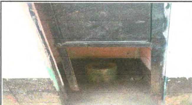
Foto 1: Reparación de Baños
