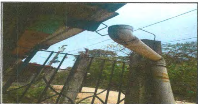
Foto 5: Reparación de canales
