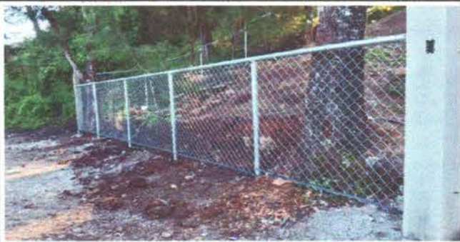
Foto 5: Mejoramiento de la circulación del centro educativo.
