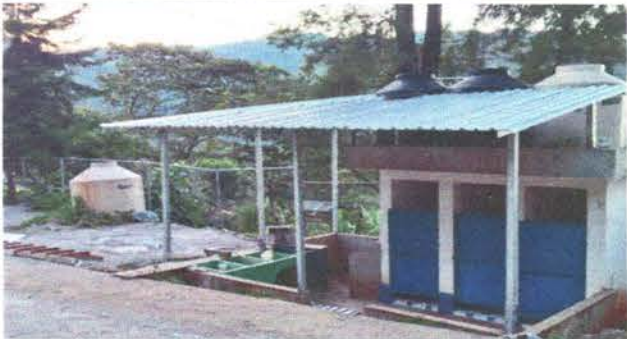
Foto 4: Colocación de nuevo techo del baño del centro educativo.
