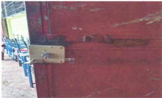
Foto 3: Mantenimiento de puertas. Cambio de chapas.
