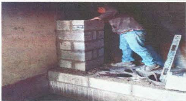
Foto 5: Mejoramiento de Plancha de la cocina.
