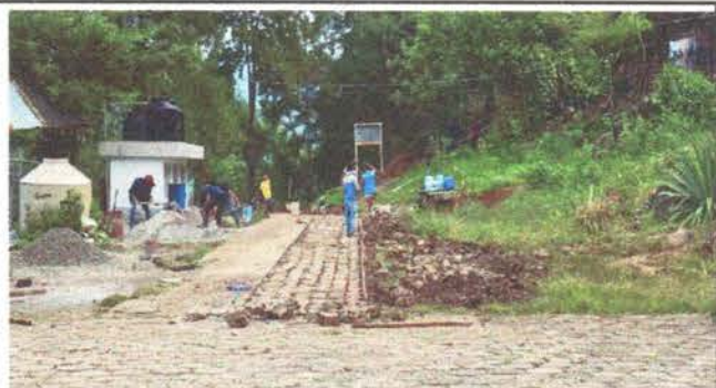
Foto 3: Reparación de torta de concreto de la entrada al centro educativo.
