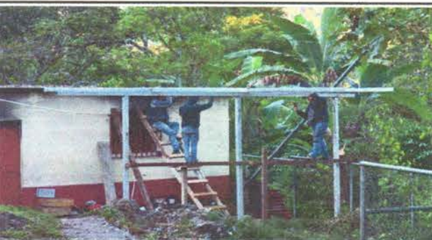
Foto 4: Mejoramiento de la cocina.
