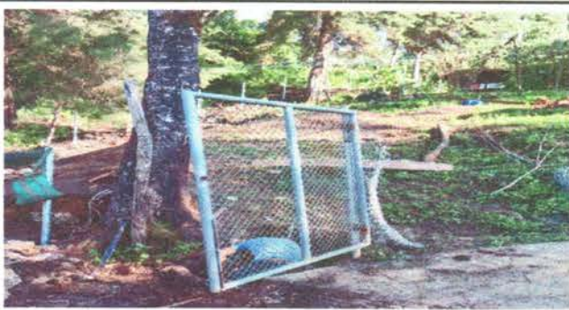
Foto 2: Proceso de reparación del porton de la entrada al centro educativo.
