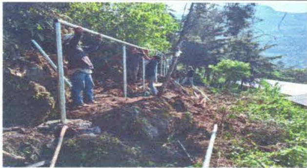
Foto1: Proceso del trabajo de reparación de circulación del centro educativo.
