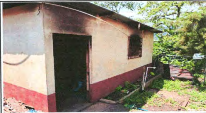
Foto 2: CUBIERTA DE LAMINA PARA COCINA
