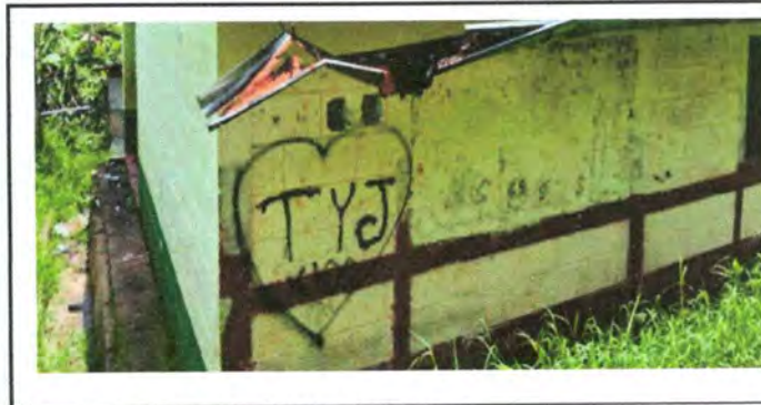
Foto 12: PINTURA DEL ESTABLECIMIENTO
