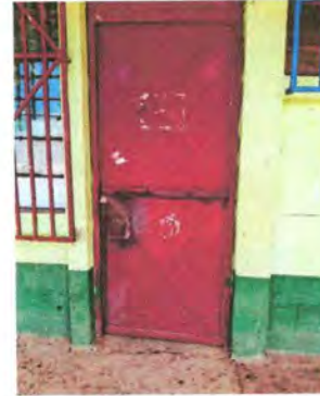
Foto 14: REMODELACIÓN DE PUERTAS
