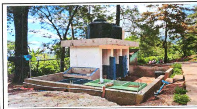
Foto 5: CUBIERTA DE LAMINA PARA BAÑOS
