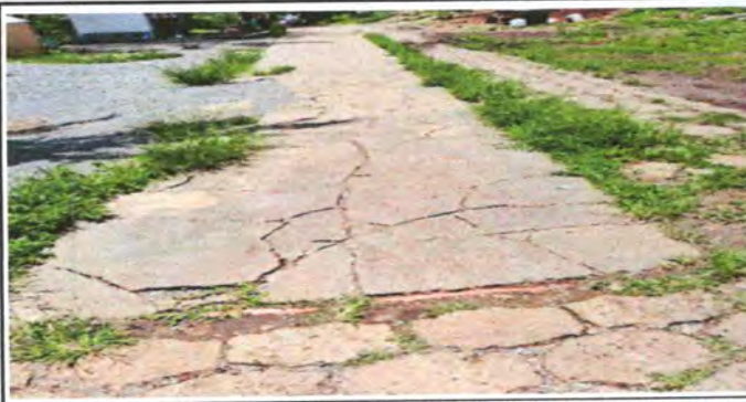
Foto 17 : TORTA DE CEMENTO PARA ENTRADA AL ESTABLECIMIENTO
