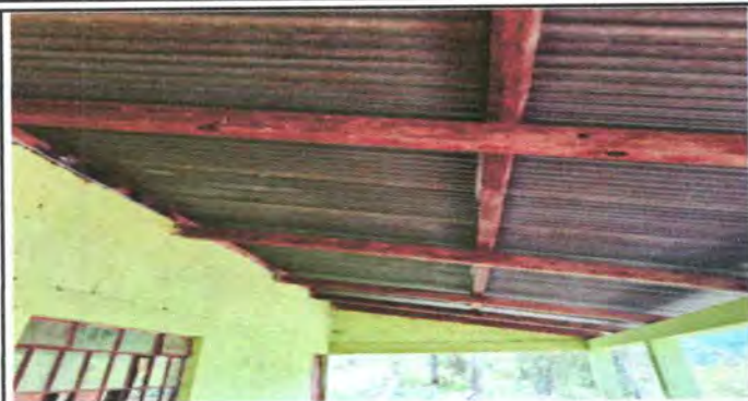
Foto 7: CUBUERTA DE LAMINA PARA UN AULA Y DIRECCIÓN
