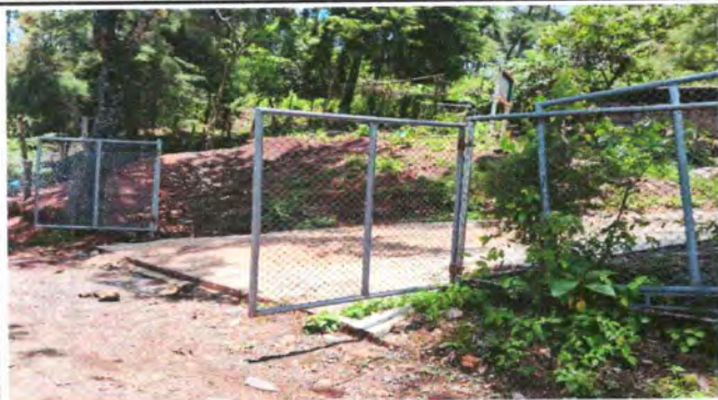
Foto 15 : REPARACIÓN DEL PORTÓN
