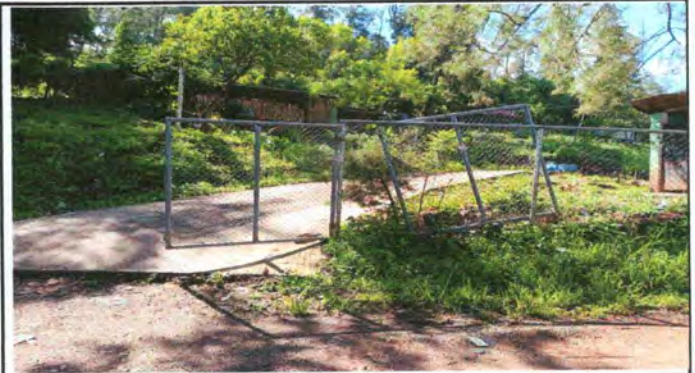
Foto 16: REPARACIÓN DEL PORTÓN
