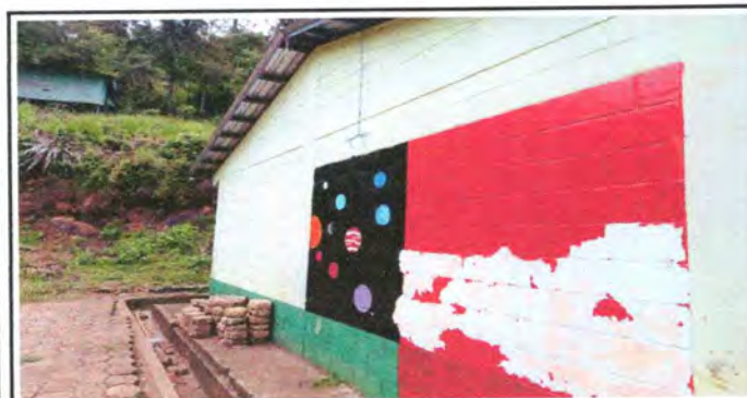
Foto 11: PINTURA DEL ESTABLECIMIENTO
