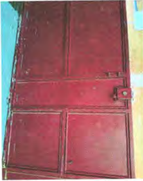
Foto 13: REMODELACIÓN DE PUERTAS
