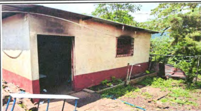
Foto1: CUBIERTA DE LAMINA PARA COCINA
