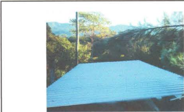
Foto 3: Sustitución de lamina
