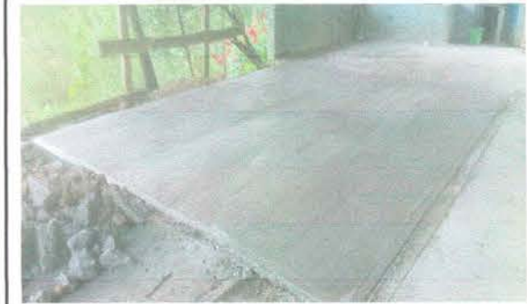
Foto 6: Reparación de planchas de concreto de patio
