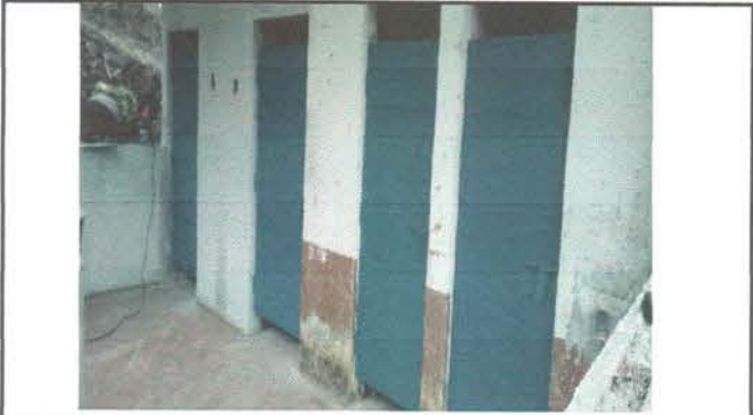
Foto 2: Sustrución de puertas en servicios sanitarios
