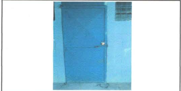
Foto 5: Sustrución de chapas
