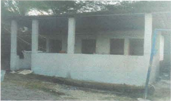
Foto1: Repello en muros
