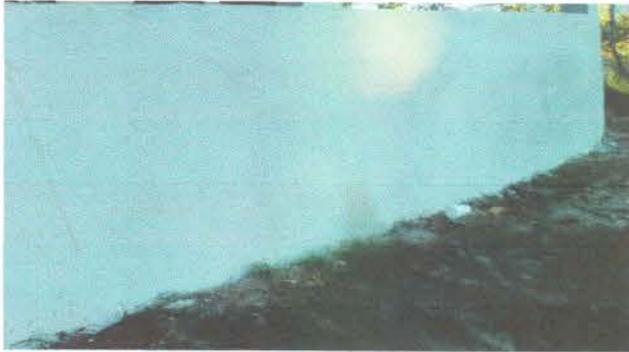
Foto 2: Repello en muros
