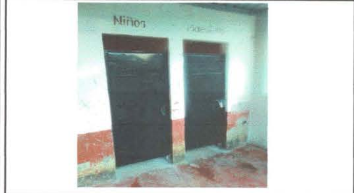
Foto1: Sustrución de puertas en servicios sanitarios
