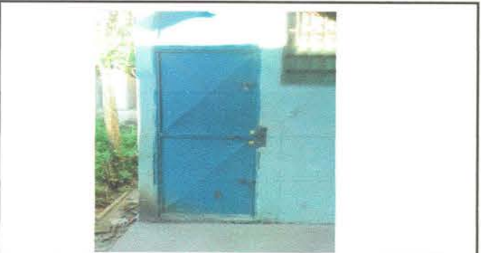
Foto 6: Sustrución de chapas
