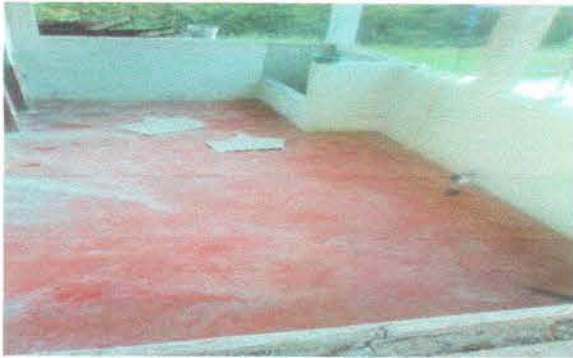
Foto 4: Reparación de planchas de concreto
