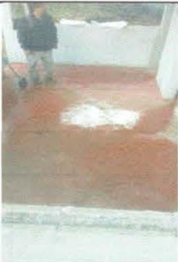
Foto 3: Reparación de planchas de concreto
