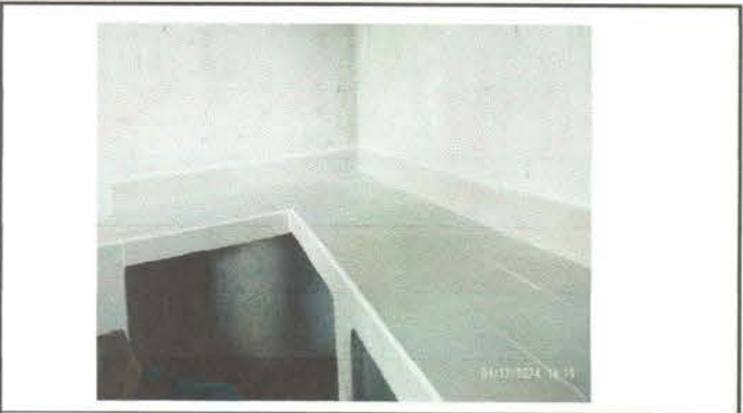
Foto 4: Reparación de cocina
