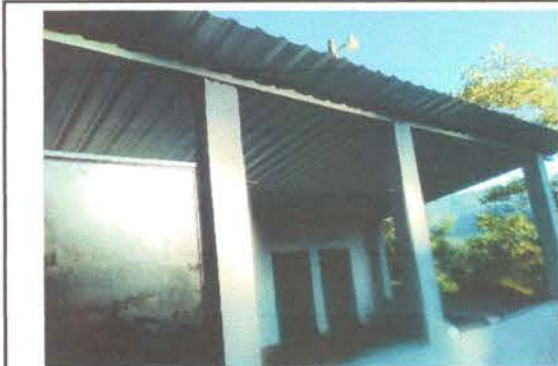
Foto 4: Sustitución de lamina
