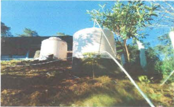
Foto 6: Sustitución de depósito de agua
