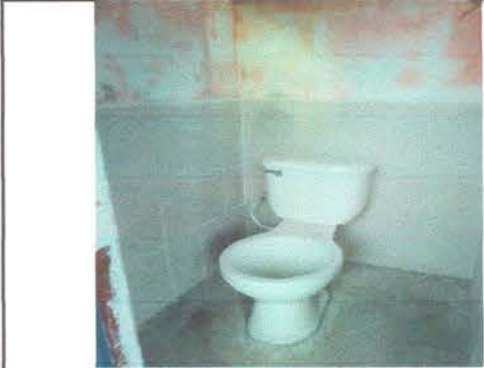
Foto 2: Sustitución de inodoros
