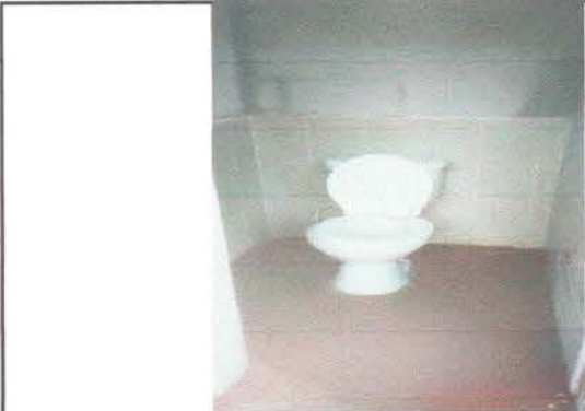
Foto1: Sustitución de inodoros
