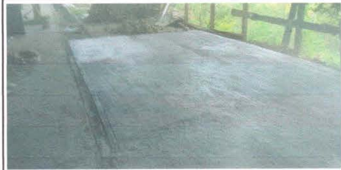
Foto 5: Reparación de planchas de concreto de patio
