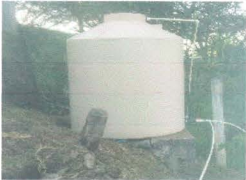
Foto 5: Sustitución de depósito de agua
