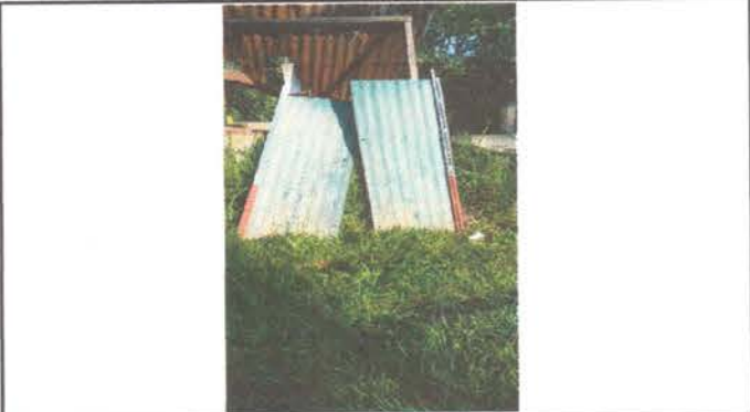
Foto1: Sustitución de puertas en servicios sanitarios
