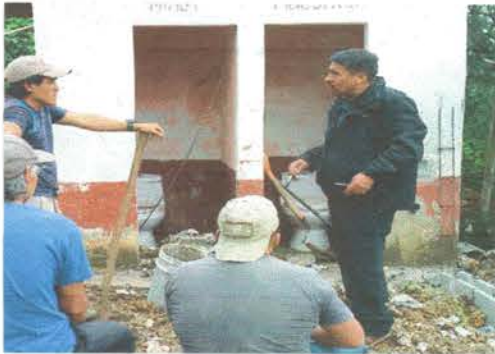
Foto 2: Sustitución de inodoros
