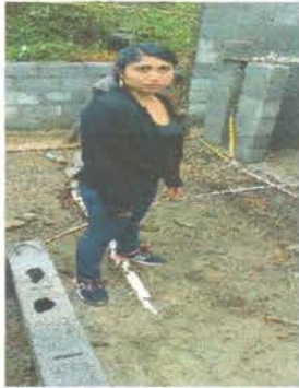
Foto 4: Reparación de planchas de concreto
