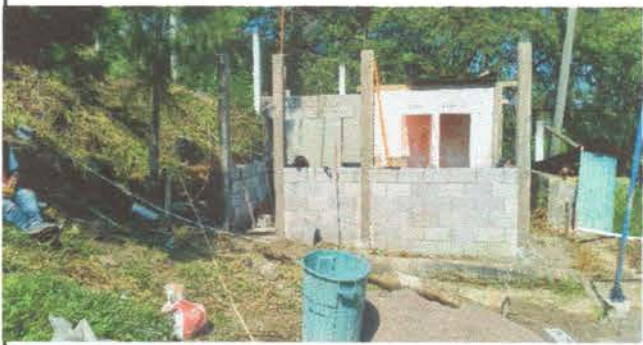
Foto 3: Sustitución de lamina
