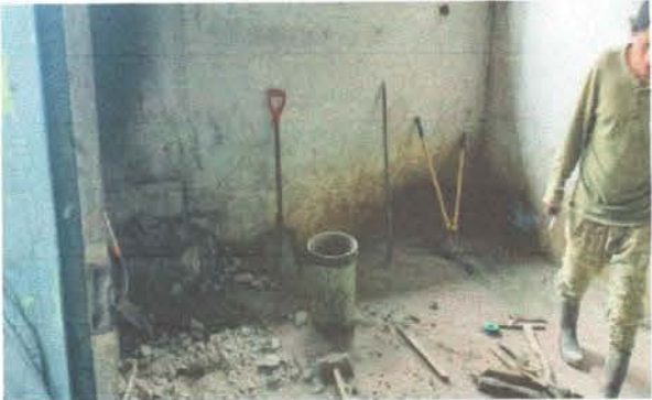
Foto 3: Reparación de cocina
