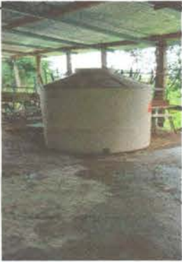
Foto 5: Sustitución de depósito de agua
