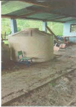
Foto 6: Sustitución de depósito de agua
