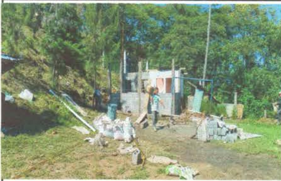
Foto 4: Sustitución de lamina
