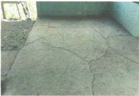
Foto 5: Reparación de planchas de concreto de patio
