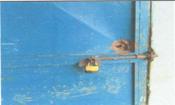
Foto 5: Sustitución de chapas
