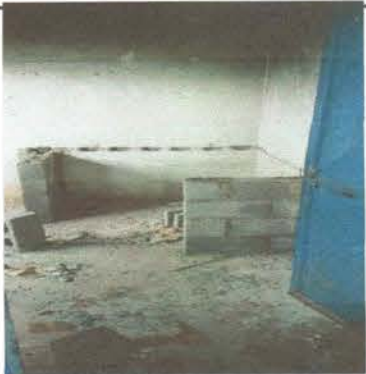
Foto 4: Reparación de cocina
