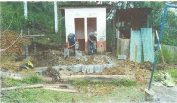
Foto 3: Reparación de planchas de concreto
