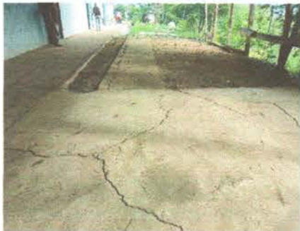
Foto 6: Reparación de planchas de concreto de patio
