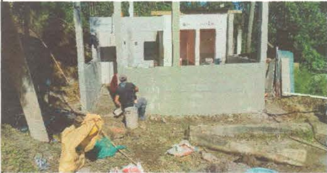
Foto 2: Repello en muros
