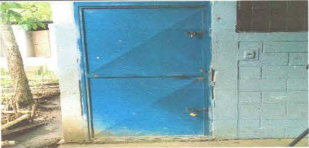
Foto 6: Sustitución de chapas
