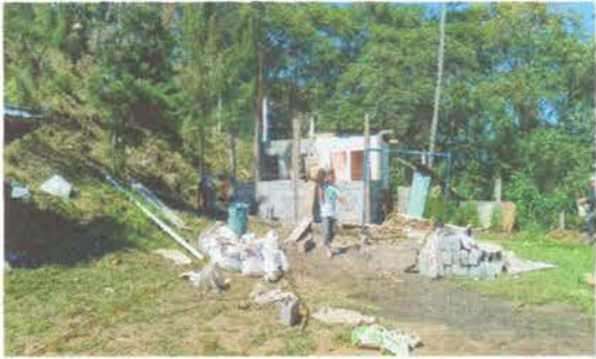
Foto 1: Repello en muros
