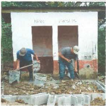
Foto1: Sustitución de inodoros
