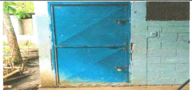
Foto 6: reparacion de puertas de metal
