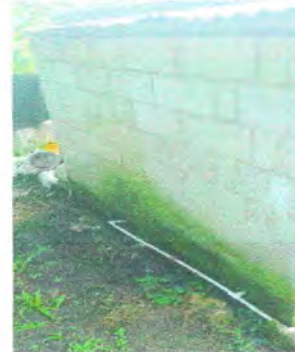
Foto 2: Reparacion de repello y cernido de paredes
