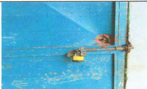
Foto 5: Sustrucción de chapas
