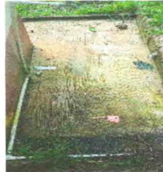
Foto 4: Reparacion de planchas de concreto
