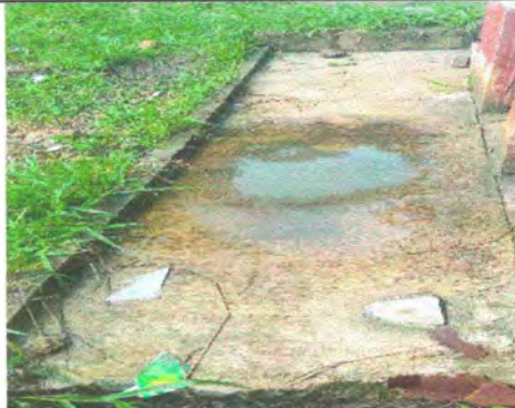
Foto 3: Reparacion de planchas de concreto
