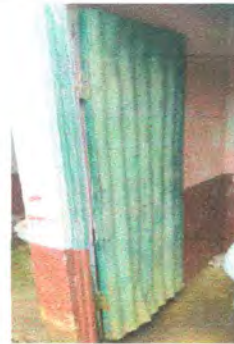
Foto 2: Sustrucción de puertas en servicios sanitarios
