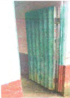
Foto1: Sustrucción de puertas en servicios sanitarios
