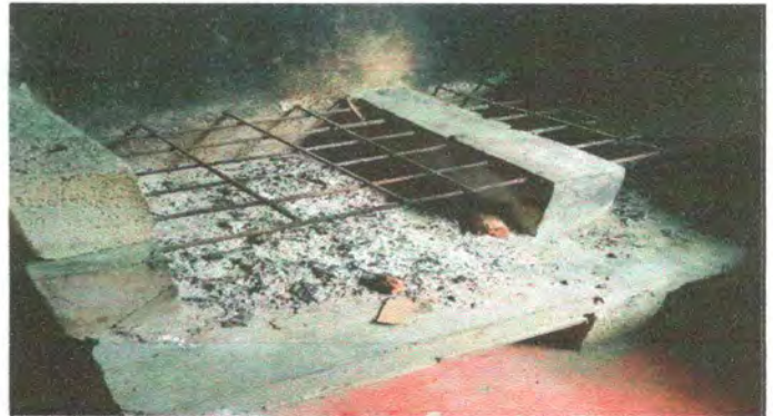
Foto 4: reparacion de cocina
