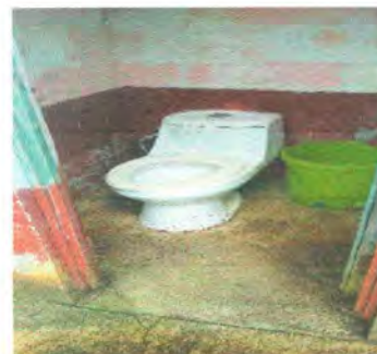
Foto 6: Sustitucion de inodoros
