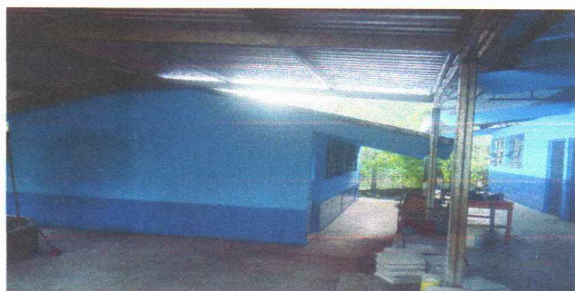
Foto1: PINTADO DE MURO EXTERIORES E INTERIORES
