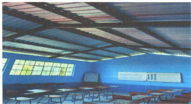
Foto 3: CAMBIO DE LAMINA POR LAMINA TROQUELADA
