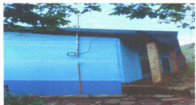
Foto 3: CAMBIO DEL SISTEMA ELECTRICO
