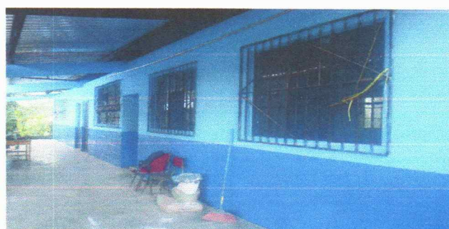
Foto 2: PINTADO DE MURO EXTERIORES E INTERIORES
