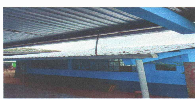
Foto 6: CAMBIO DE CANAL DE METAL POR CANAL COLONIAL
