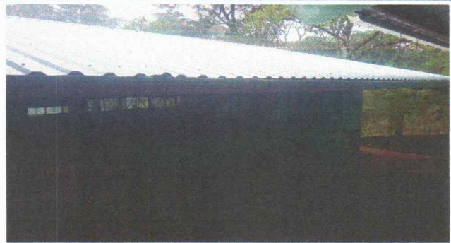
Foto 4: CAMBIO DE LAMINA POR LAMINA TROQUELADA
