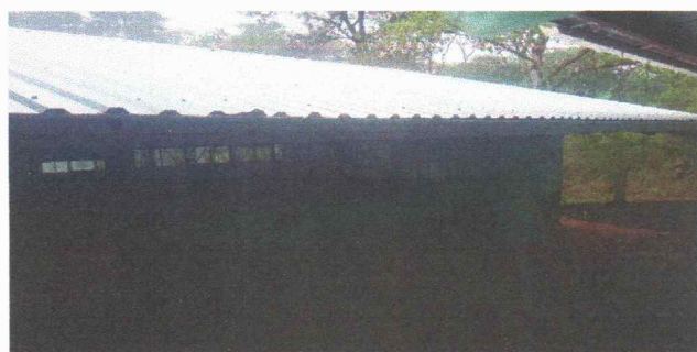
Foto 5: CAMBIO DE CANAL DE METAL POR CANAL COLONIAL
