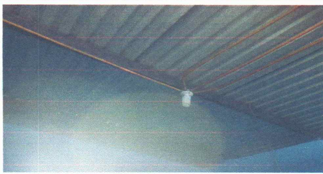
Foto 4: CAMBIO DEL SISTEMA ELECTRICO
