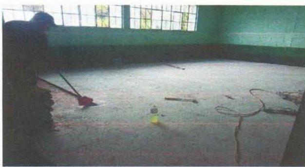
Foto1: CAMBIO DE PISO DE CONCRETO POR PISO DE GRANITO
