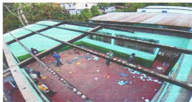
Foto 3: CAMBIO DE TECHO DE LAMINA POR LAMINA TROQUELADA
