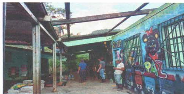
Foto 5: CAMBIO DE CANAL DE METAL POR CANAL COLONIAL
