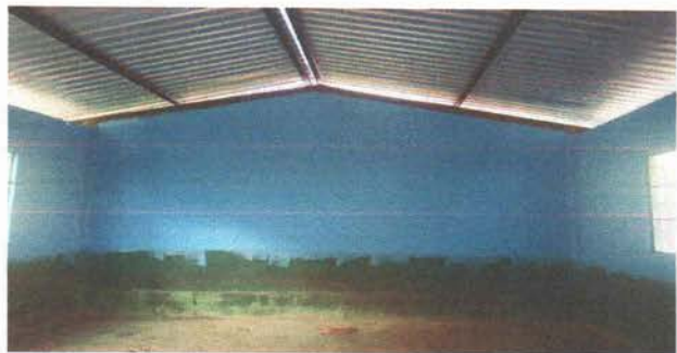
Foto1: PINTADO DE MURO EXTERIORES E INTERIORES
