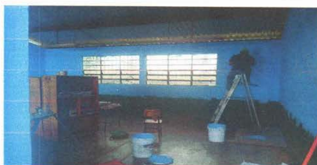
Foto 2: PINTADO DE MURO EXTERIORES E INTERIORES
