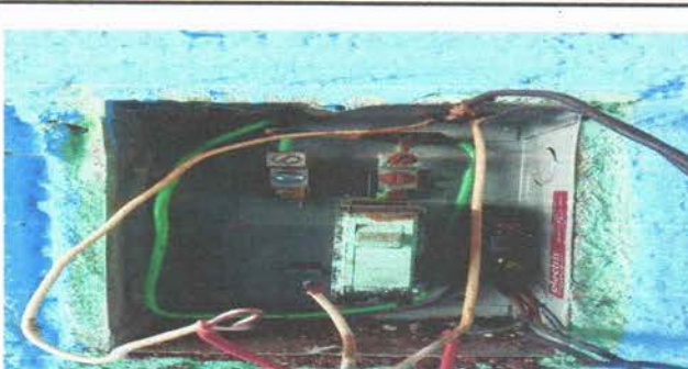
Foto 4: CAMBIO DEL SISTEMA ELECTRICO
