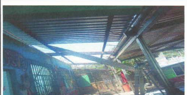
Foto 4: CAMBIO DE TECHO DE LAMINA POR LAMINA TROQUELADA
