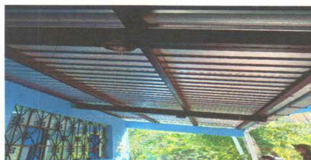
Foto 6: CAMBIO DE CANAL DE METAL POR CANAL COLONIAL
