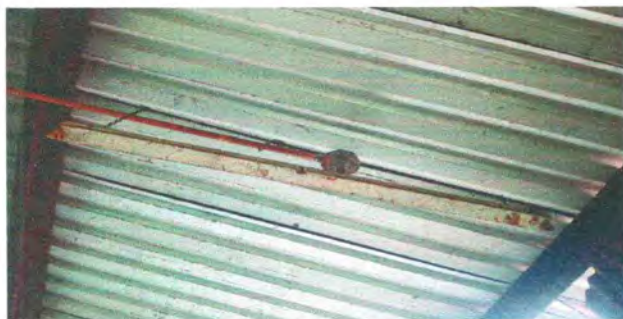
Foto 3: CAMBIO DEL SISTEMA ELECTRICO
