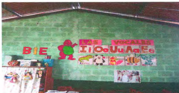
Foto1: PINTADO DE MURO EXTERIORES E INTERIORES
