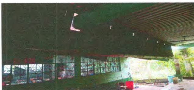
Foto 5: CAMBIO DE CANAL DE METAL POR CANAL COLONIAL
