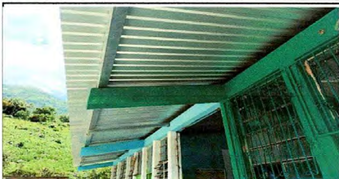
Foto1: Lámina por lámina troquelada aluzinc calibre 26
