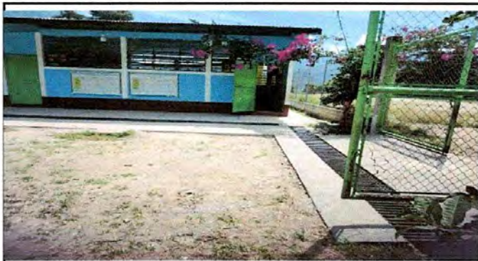
Foto7: Cuneta de concreto
