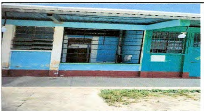
Foto 3: Estructura de metal de ventana
