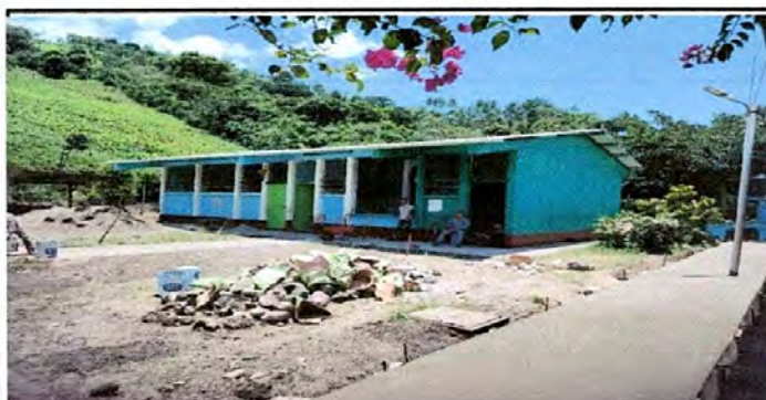
Foto 5: Sustitución de canal de PVC
