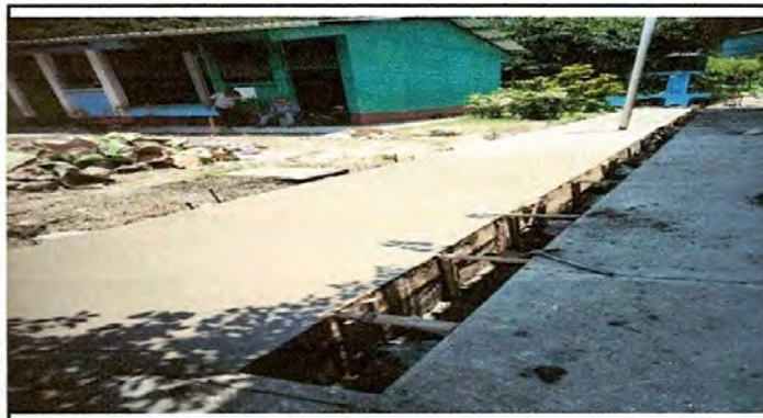
Foto 8: Reparación de plancha de concreto de patio
