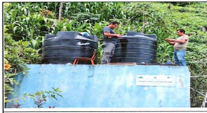
Foto 12: Sustitución de deposito de agua 1,700 lt.
