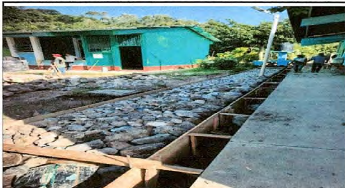
Foto7: Reparación de cuneta de concreto
