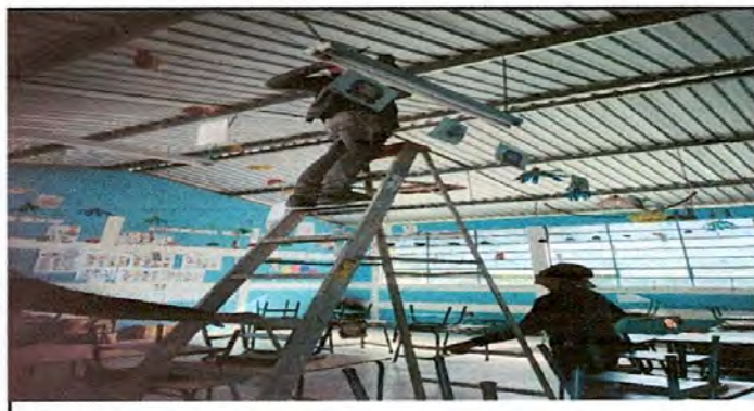
Foto 10: Sustitución de focos ahorradores
