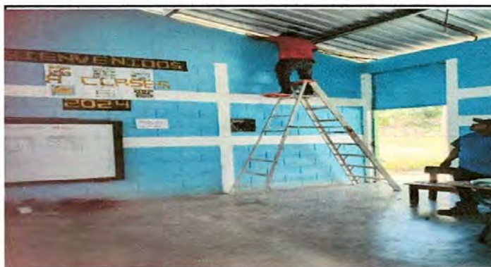
Foto 9: Sustitución de flípones
