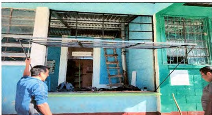
Foto 3: Cambio de estructura de metal de ventana
