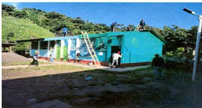
Foto 1: Cambio de lámina por lámina troquelada aluzin calibre 26
