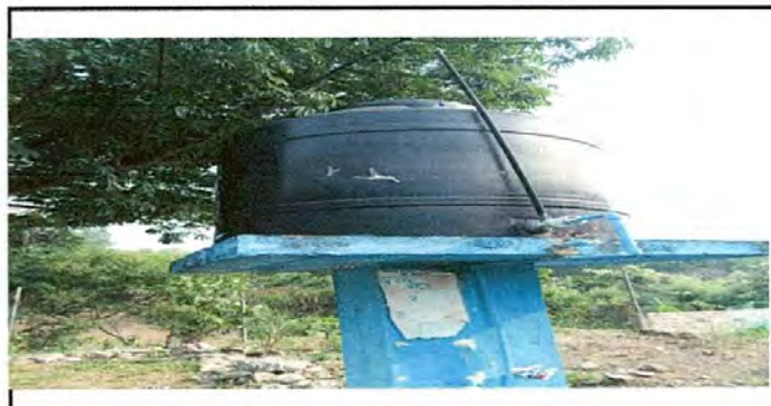
Foto 12: Sustitución de depósito de agua 1,700 lt.
