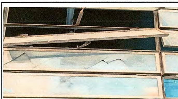
Foto 4: Cambio de vidrio
