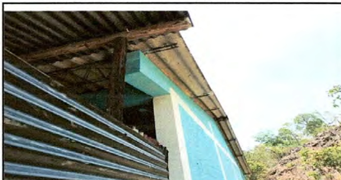
Foto 2: Cambio de estructura de soporte de metal por metal
