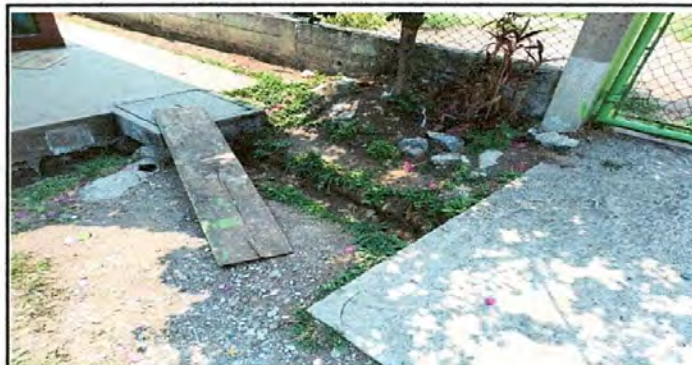
Foto 8: Reparación de plancha de concreto de patio
