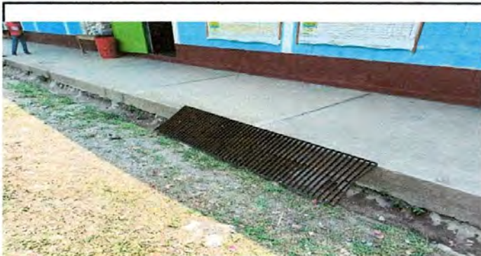
Foto 7: Reparación de cuneta de concreto
