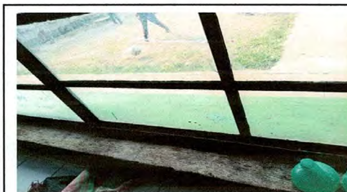
Foto 3: Cambia de estructura de metal de ventana
