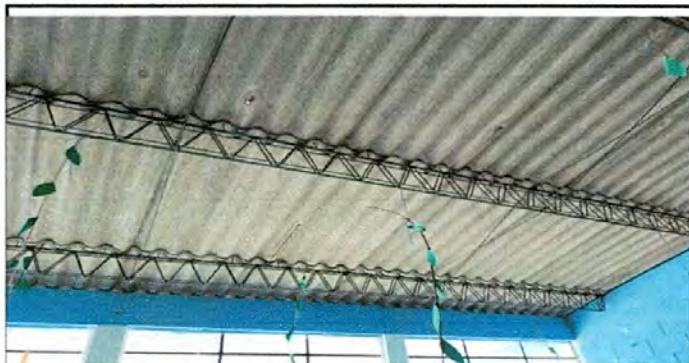
Foto 1: Cambio de lámina, por lamina troquelada aluzinc calibre 26
