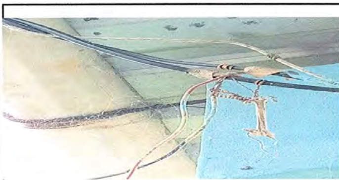
Foto 11: Reparación de cableado eléctrico
