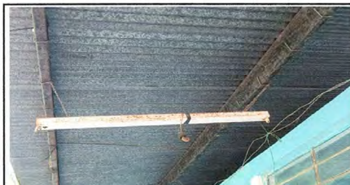
Foto 10: Sustitución de focos ahorradores
