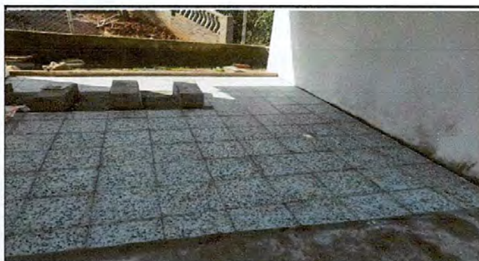
Foto 3: PISO GRANITO POR TORTA DE CEMENTO
