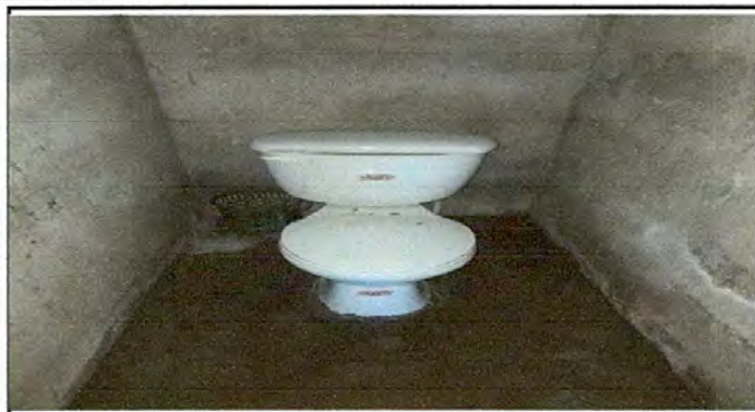
Foto 2: INODOROS NUEVOS INSTALADOS
