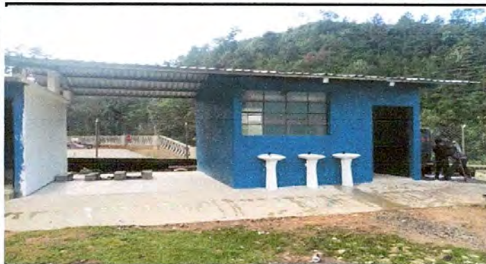
Foto1: LÁMINA TROQUELADA INSTALADA
