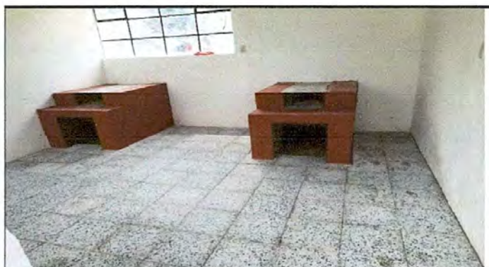
Foto 4: ESTUFA RURAL COMPLETA INSTALADA
