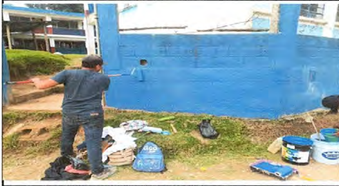
Foto1: APLICACIÓN DE PINTURA EN MUROS
