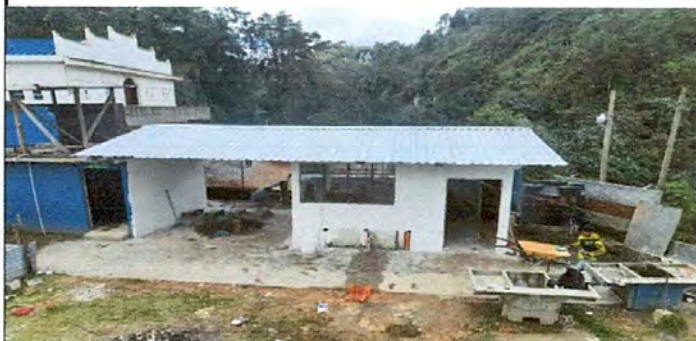
Foto1: COLOCACIÓN DE LÁMINA
