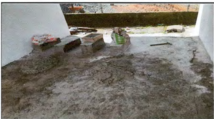
Foto 3: COLOCACIÓN DE PISO GRANITO
