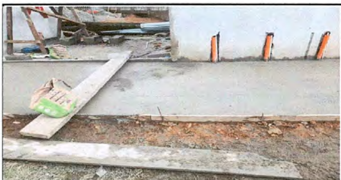
FOTO 6: COLOCACIÓN DE LAVAMANOS
