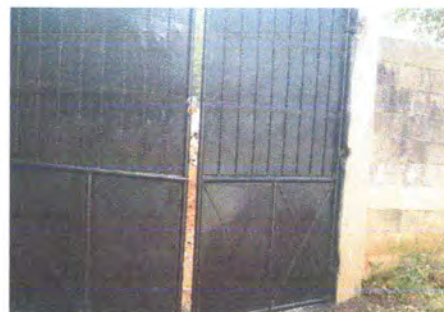
Foto 6: Sustitución de portón
