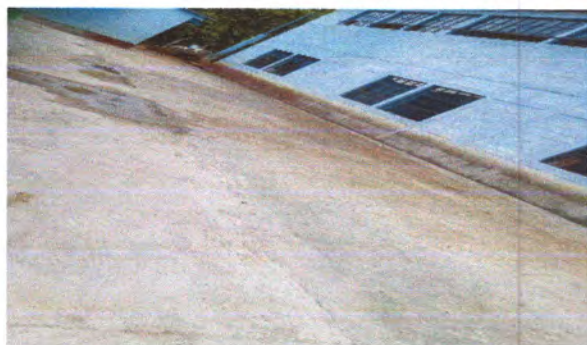
Foto 5: sustitución de pavimento en el corredor
