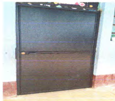
Foto2: sustitución de puertasde metal
