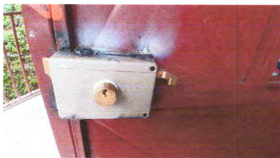
Foto 3: Sustitución de chapas en puertas
