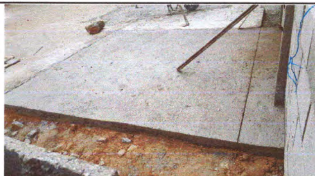
Foto 4. Torta de cemento de 3 metros por 4
