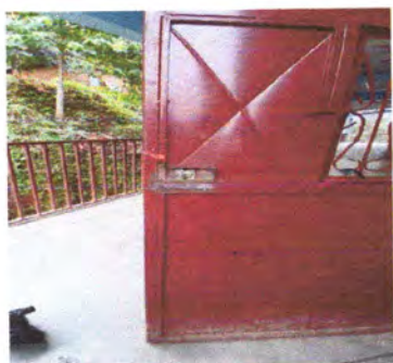
Foto 3: Cambio de chapa de puerta de metal
