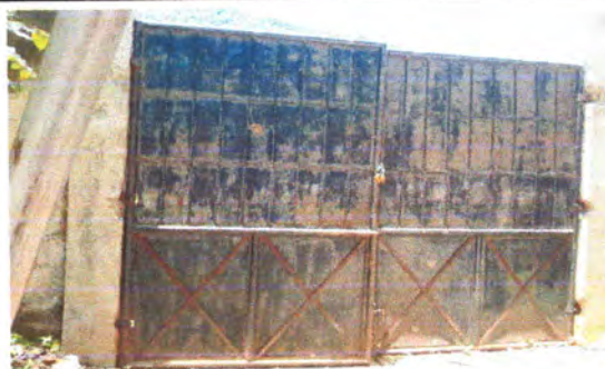
Foto 6: Cambio de porton de metal
