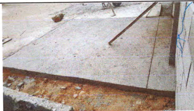
Foto 4: Torta de cemento de 3 metros por 4
