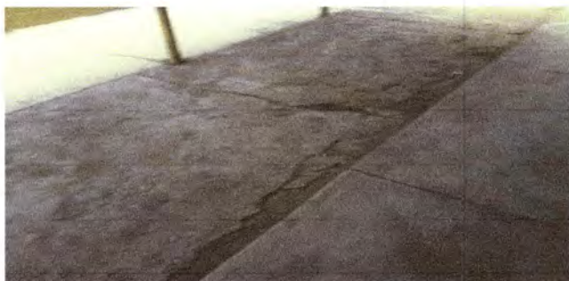
Foto 5: Sustitución de pavimento de corredor
