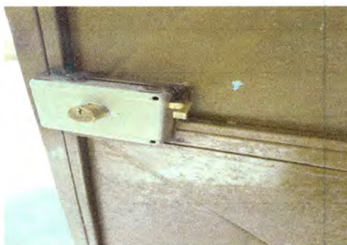
Foto 3 Sustitución de chapa de puerta de metal
