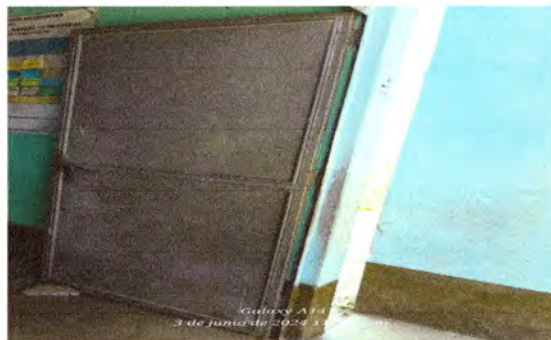
Foto 2. Sustitución de puerta de metal
