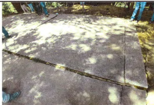
Foto 4 Sustitución de pavimento de cancha
