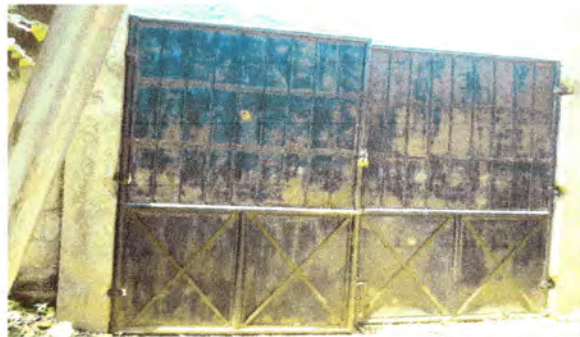
Foto 6: Sustitución de puertas
