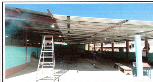
Foto 5: SUSTITUCIÓN DE ESTRUCTURA DE SOPORTE DE TECHO
