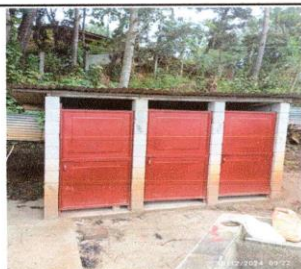
Foto 3: SUSTITUCIÓN DE PUERTAS
