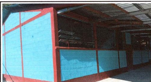
Foto 1: SUSTITUCIÓN DE VIDRIOS
