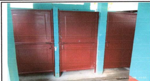
Foto 1: SUSTITUCIÓN DE PUERTAS
