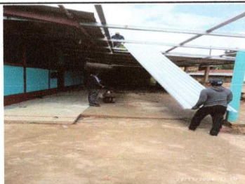
Foto 5: SUSTITUCIÓN DE ESTRUCTURA DE SOPORTE DE TECHO
