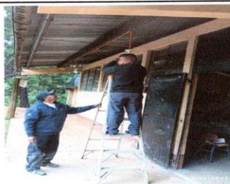
Foto 6: SUSTITUCIÓN DE FOCOS
