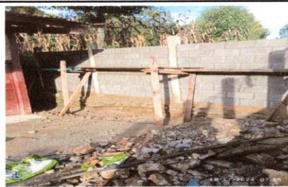
Foto 2: MEJORAMIENTO DE PARED
