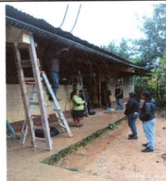
Foto 4: REPARACIÓN DE CABLEADO ELÉCTRICO
