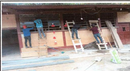
Foto1: SUSTITUCIÓN DE VIDRIOS
