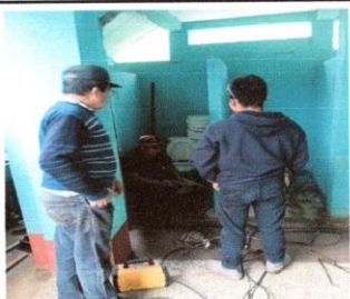
Foto1: SUSTITUCIÓN DE PUERTAS
