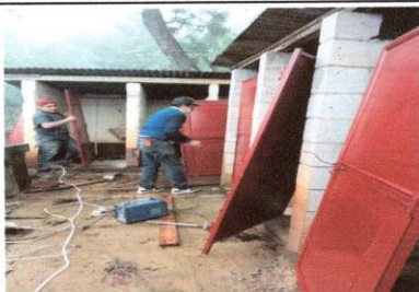
Foto 3: SUSTITUCIÓN DE PUERTAS
