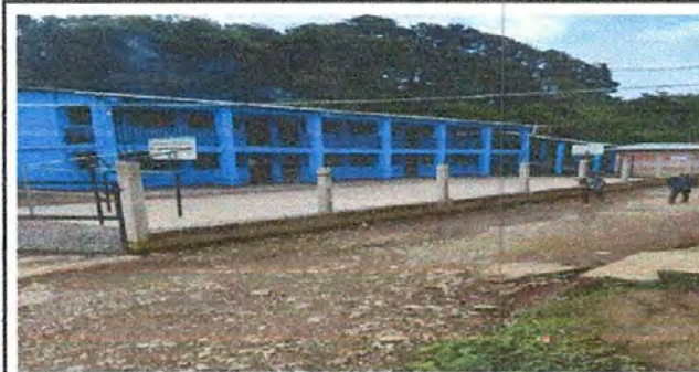
FOTO. 5 MANTENIMIENTO EN MURO
