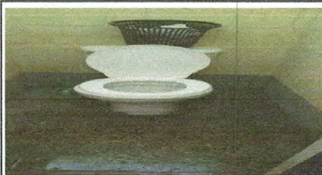
FOTO. 1 REPARACION DE INODOROS Y MANTENIMIENTO DE DRENAJE
