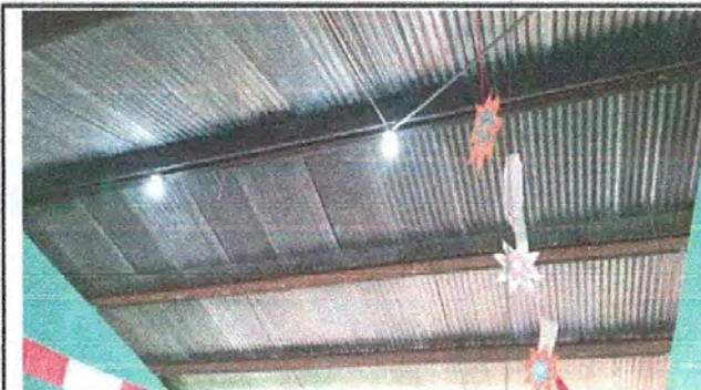
FOTO. 3. REPARACION DE SISTEMA ELECTRICO
