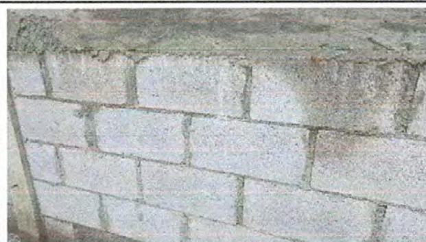
FOTO. 8 REPARACION DE MUROS PERIMETRAL DE BLOK.
