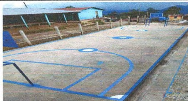
Foto. 6 Reconstruccion de patio
