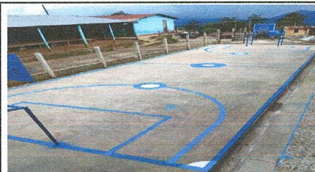
Foto. 6 Reconstruccion de patio
