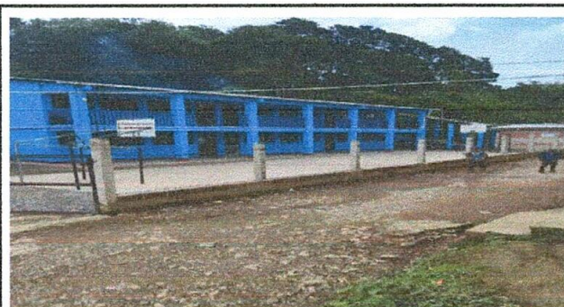
FOTO. 4. MANTENIMIENTO DE PINTURA EN MURO
