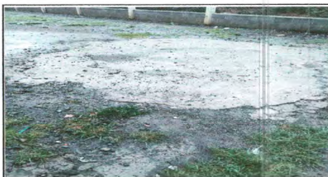
Foto. 6 Reconstruccion de patio
