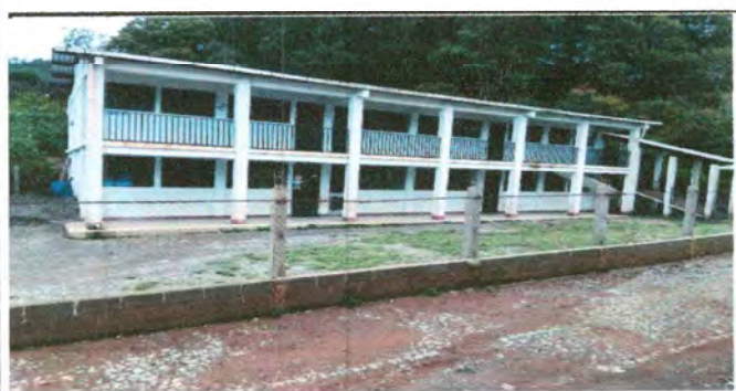
Foto 5: Mejoramiento de pintura en muros
