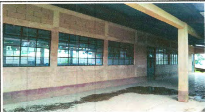
Foto 3: Mejoramiento de pintura en muros
