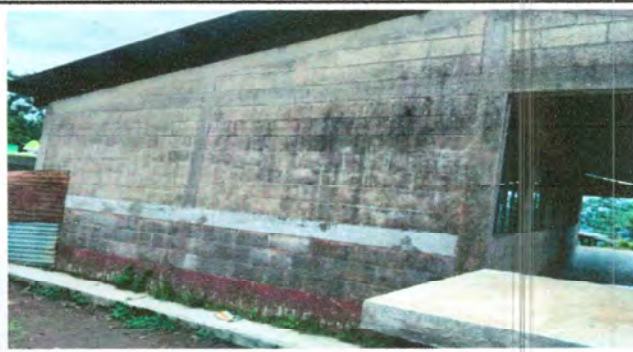
Foto 4: Mejoramiento de pintura en muros
