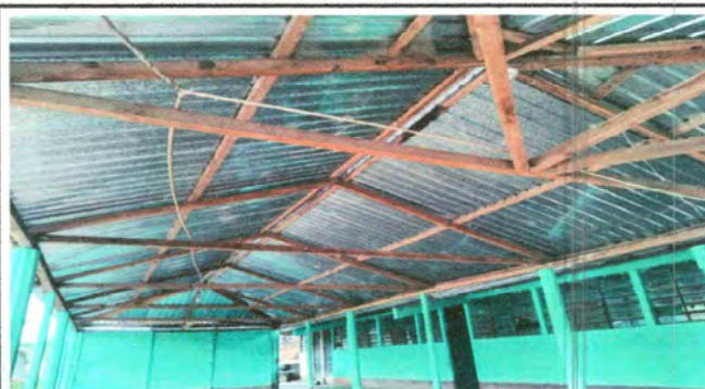
FOTO.2 REPARACION DE SISTEMA ELECTRICO.
