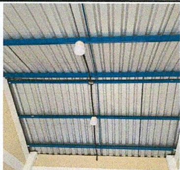
Foto 5. Sustitución de lámparas
