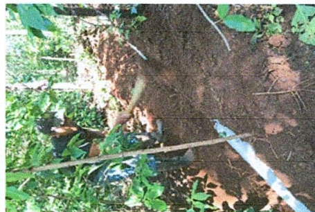
Foto 4. Sustitución de tubo pvc línea principal de aguas negras
