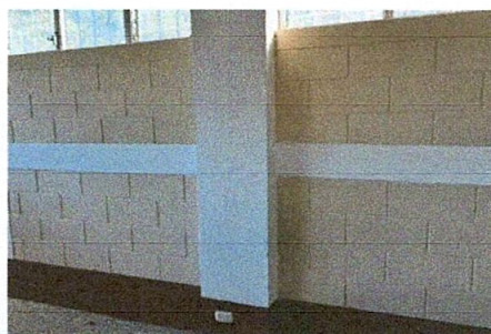
Foto 2. Pintado de muros interiores
