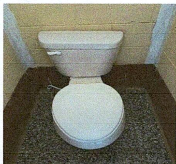
Foto 3. Sustitución de accesorios de baño
