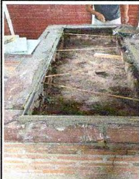
Foto 1: sustitución de plancha en cocina
