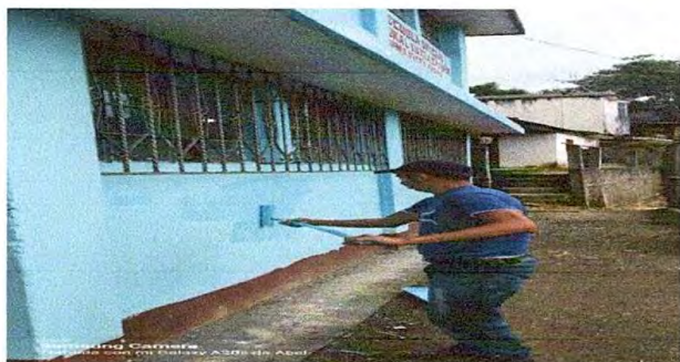
Foto 7: sustitución de pintura en muros exteriores e interiores
