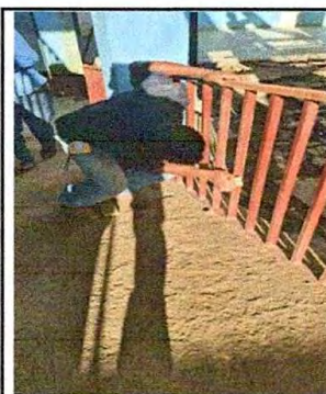
Foto 3: mantenimiento de Barandas
