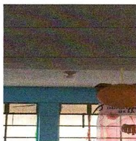
Foto 5: sustitución de flafoneras y focos
