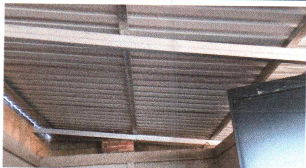
Foto 1: Cubierta de lámina en cocina
