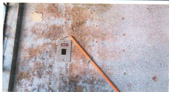
Foto 3: Reparación de sistema eléctrico
