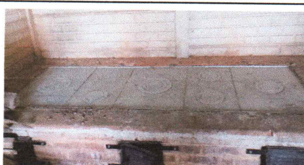
Foto 4: Sustitución de plancha de metal de 5 honillas
