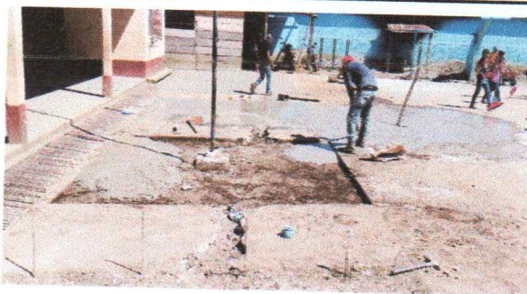
Foto 6: Reparación de cisterna de concreto y losa de patio
