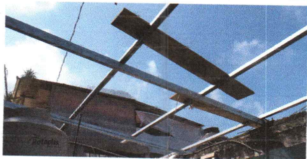
Foto1: Cubierta de lámina en cocina
