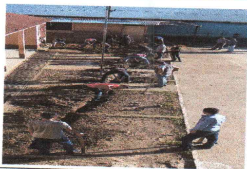
Foto 5: Reparación de red de drenaje
