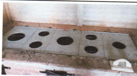
Foto 4: Sustitución de plancha de metal de 5 piezas
