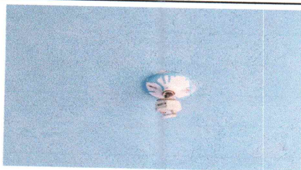
Foto 3: Reparación de sistema eléctrico
