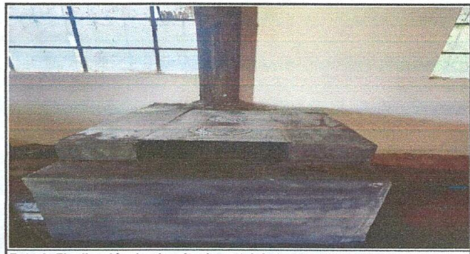
Foto 6: Finalización de plancha de metal de tres ornillas.
