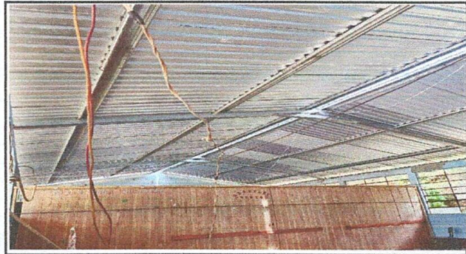
Foto 4: Finalización de colocación de lámina troquelada zinc calibre 26, capotes de lamina y estructura de metal en Módulo 1.
