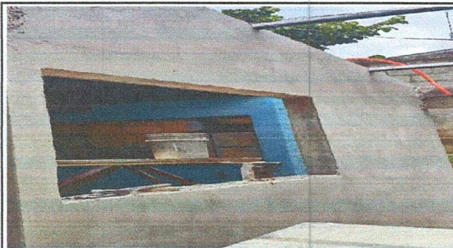
Foto 3: Colocación de cernido y repello en paredes de cocina.
