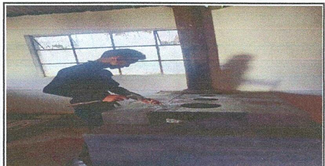
Foto 6: Colocación de plancha de metal de tres ornillas.
