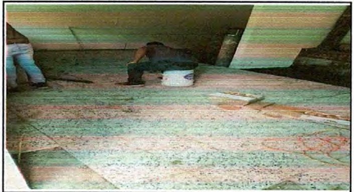
Foto 8: Avanzando con la sustitución de piso de torta por granito
