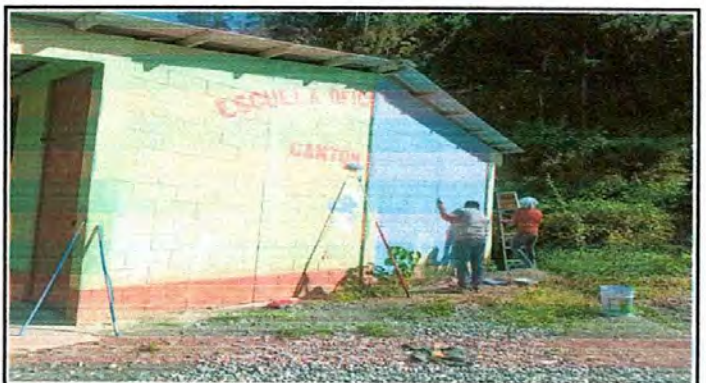
Foto 10: Pintura de paredes de interiores y exteriores
