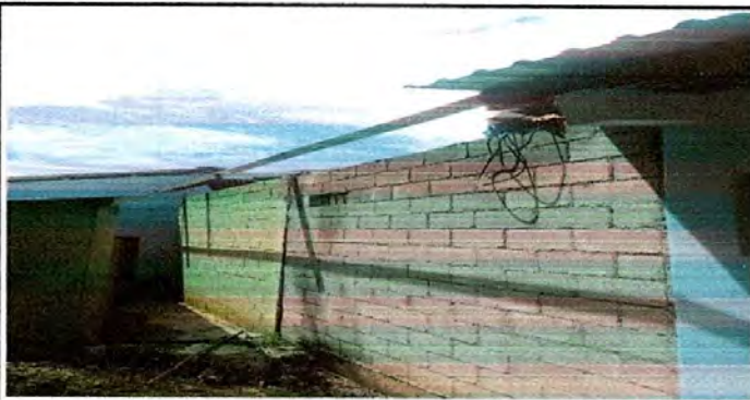
Foto 5: Mejorando paredes de cocina
