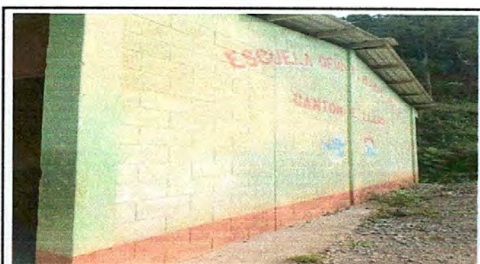
FOTO 10: Pintura de paredes exteriores e interiores
