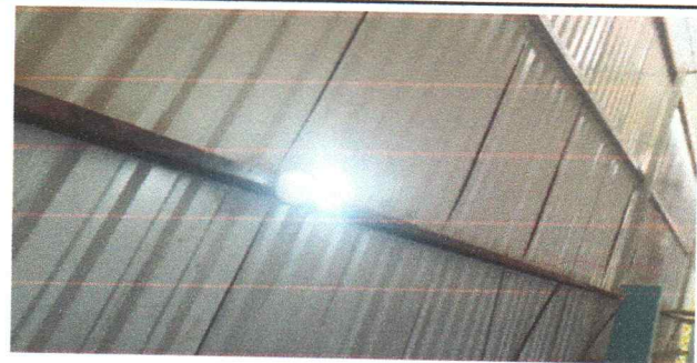
Foto 6: Reparación de Sistema Eléctrico
