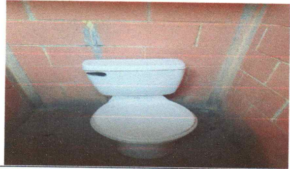
Foto 8: Sustitución de accesorios de inodoro
