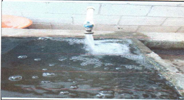
Foto 7: Sustitución de bomba de agua
