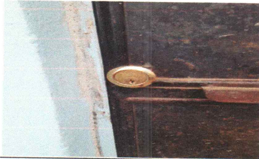
Foto1: Sustitución de chapa en puerta
