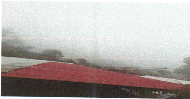
Foto 3: Sustitución de lámina
