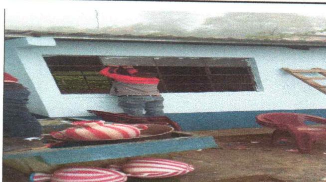
Foto 4: Sustitución de vidrios
