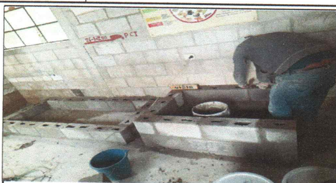
Foto 2: Sustitución de estufa rural completa
