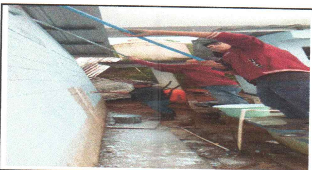
Foto 5: Pintura en muros exteriores e interiores
