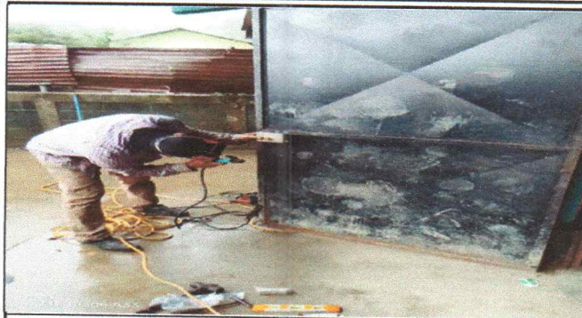
Foto1: Sustitución de chapa en puerta
