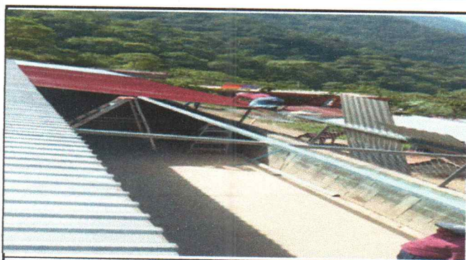
Foto 3: Sustitución de lámina
