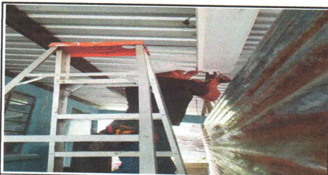
Foto 6: Reparación de Sistema Eléctrico
