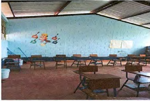
Foto 7: pintura en muros exteriores e interiores.
