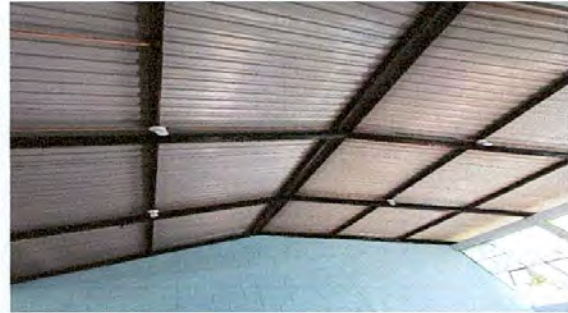
Foto. 10: Sustitución de plafoneras.
