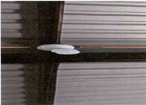
Foto 9: Sustitución de lamparas tipo led.
