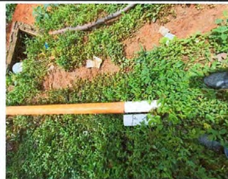
Foto 4: Sustitución de tubería PVC.
