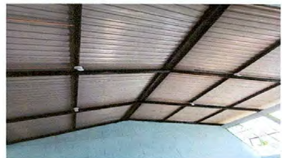
Foto 6: Reparación de cableado eléctrico
