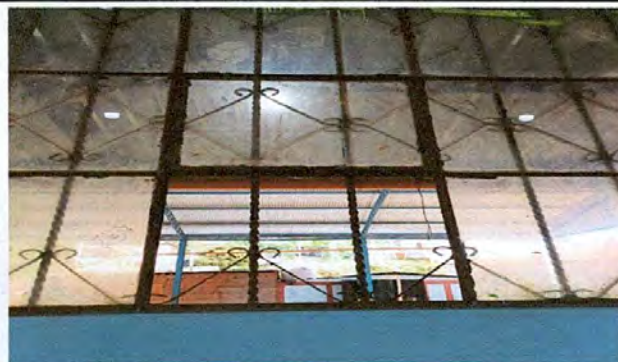
Foto 5: Mantenimiento de balcones
