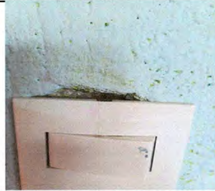
Foto 8: Sustitución de Interruptores simples
