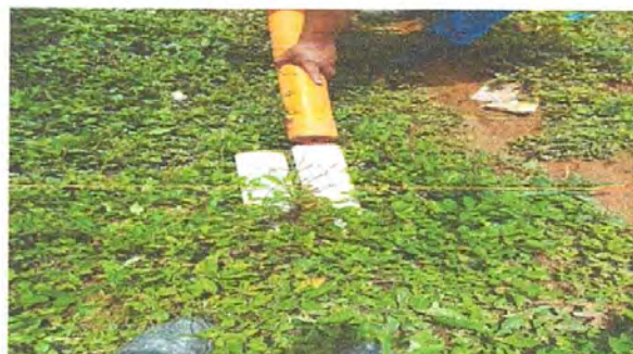
Foto 4: Sustitucion de tuveria PVC.
