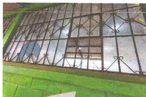
Foto 5. Sustitucion de balcones.
