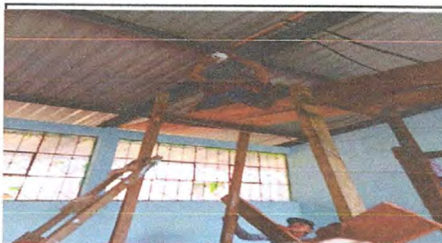
Foto 10: Situación de plafoneras
