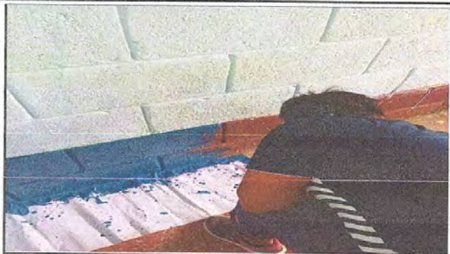
FOTO 7: Pintura en muros exteriores e interiores
