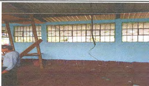
Foto 6: Sustitución de cableado eléctrico.
