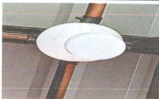
Foto 9: Sustitución de lamparas tipo LED
