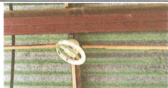
Foto 9: Sustitución de lamparas tipo LED
