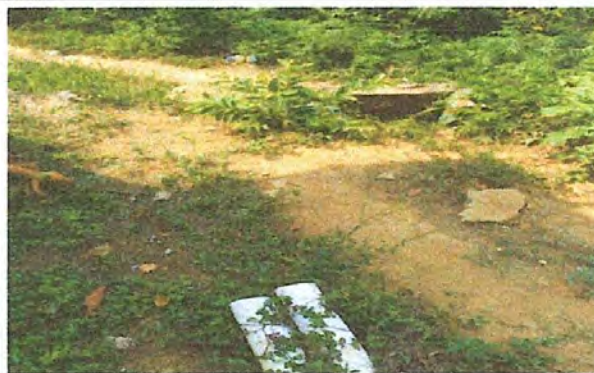
foto 4: sustitución de tubería PVC
