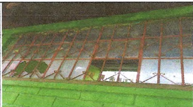
Foto 5: Sustitución de balcones de metal
