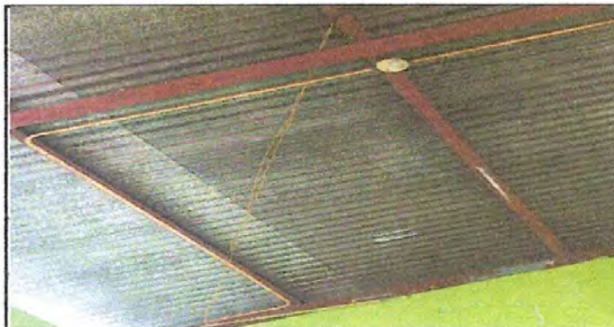
Fto 6: Reparación de cableado eléctrico
