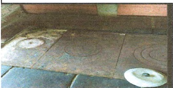
FOTO 3: Sustitución de plancha de metal de 3 hornillas
