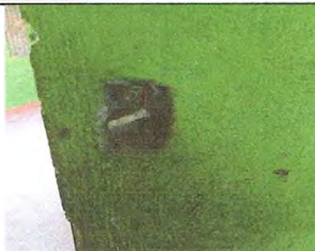
Foto 8: Situación de interruptores simples
