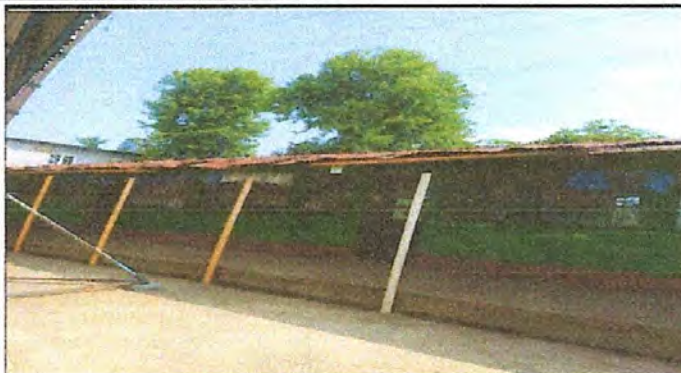
Foto 2: láminas en malas condiciones
