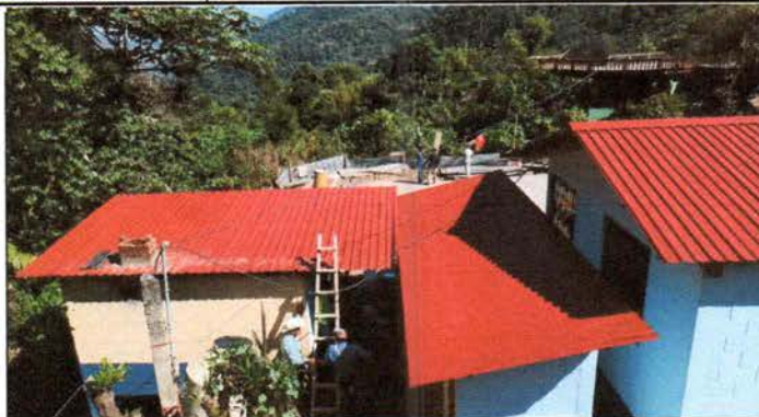
Sustitucion de Lamina
