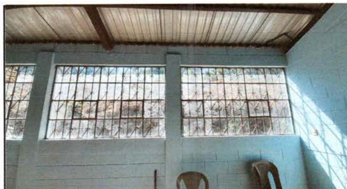
Sustitucion de ventanas
