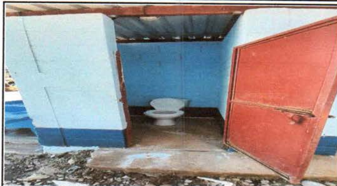
sustitucion de inodoros
