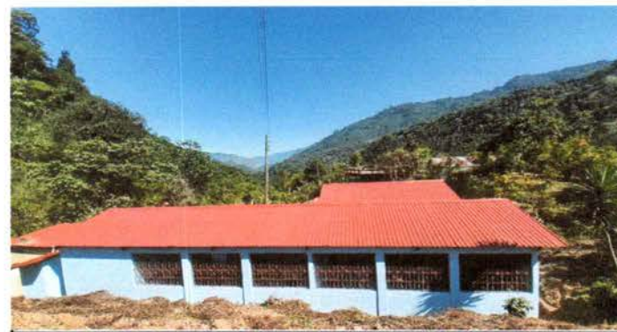
Pintura en muros interiores y exteriores
