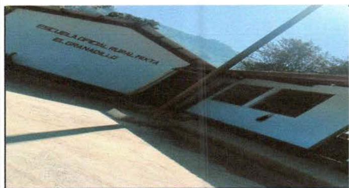
Pintura en muros exteriores e interiores
