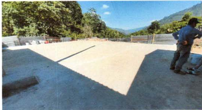
Sustitucion de piso de torta de concreto
