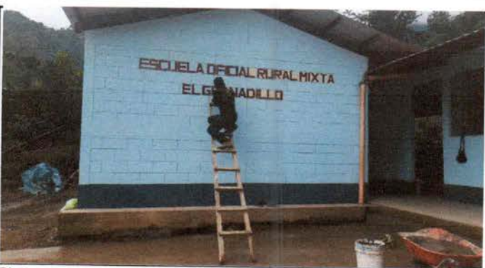
Pintura en muros exteriores e interiores
