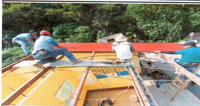
Sustitucion de Lamina
