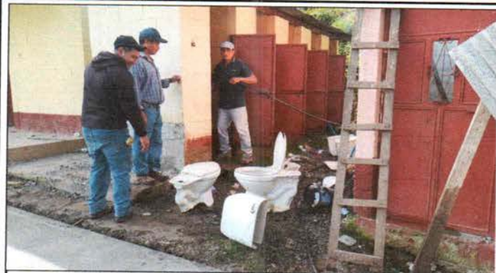
sustitucion de inodoros
