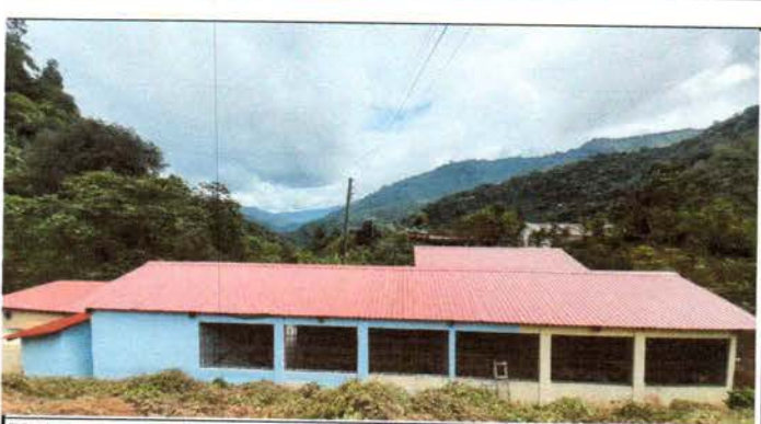
Pintura en muros interiores y exteriores
