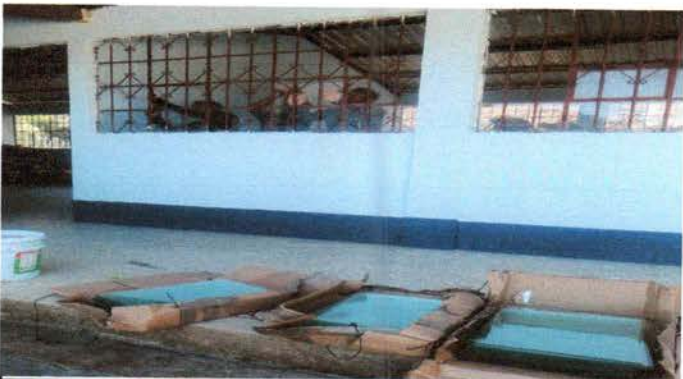
Sustitucion de ventanas
