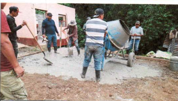
Sustitucion de piso de torta de concreto
