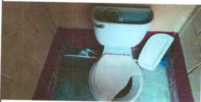
sustitucion de inodoros
