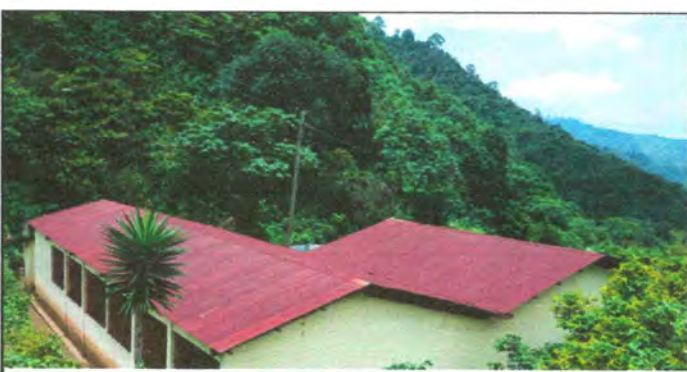
Pintura en muros interiores y exteriores
