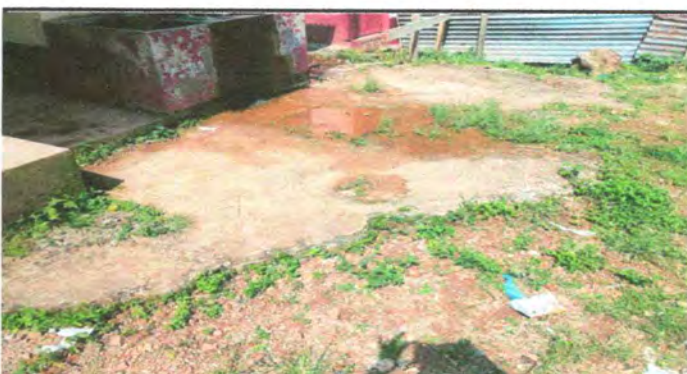
Sustitución de piso de torta de concreto
