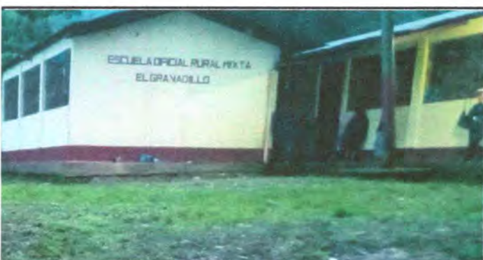
Pintura en muros exteriores e interiores
