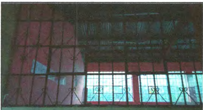
Sustitución de ventanas
