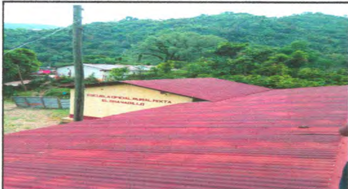
Sustitución de Lamina
