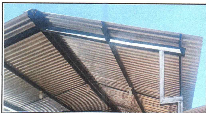
Foto 3: Mantenimiento a estructura portante de metal
