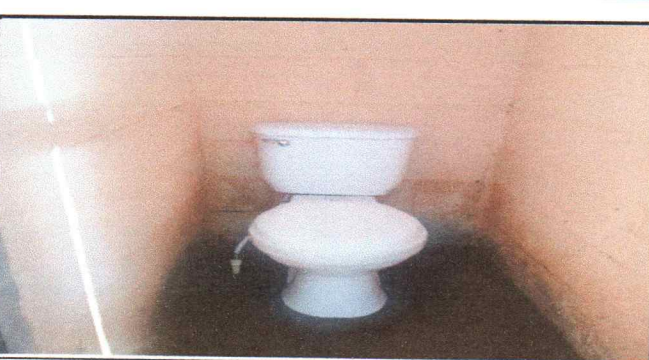
Foto 6: Sustitución de inodoros
