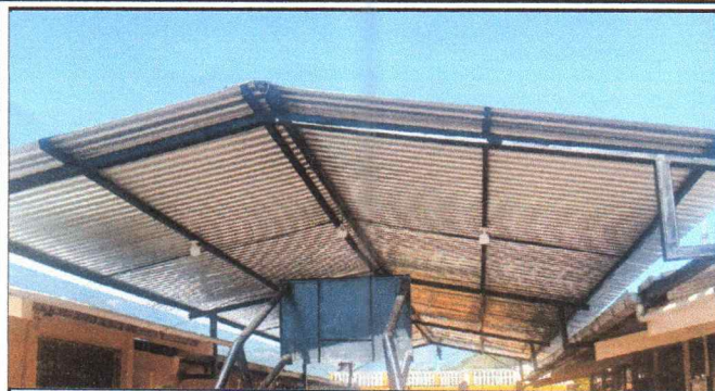
Foto 1: Sustitución de lámina por lámina troquelada calibre 26
