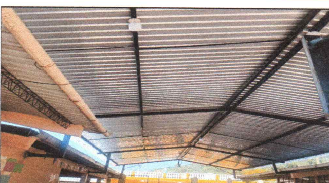
Foto 4: Sustitución y mantenimiento de energía eléctrica
