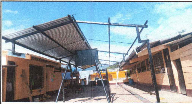
Foto 1: Sustrucción de lámina por lámina troquelada calibre 26
