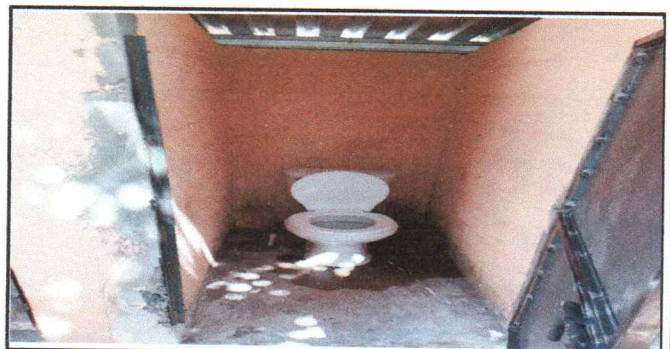
Foto 6: Sustrucción de inodoros
