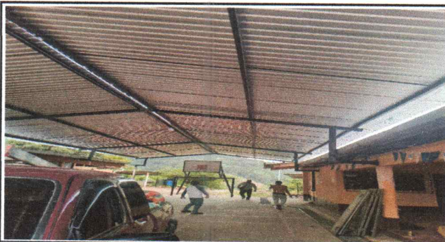
Foto 3: Mantenimiento a estructura portante de metal
