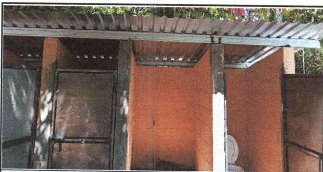
Foto 5: Sustrucción de puertas de metal
