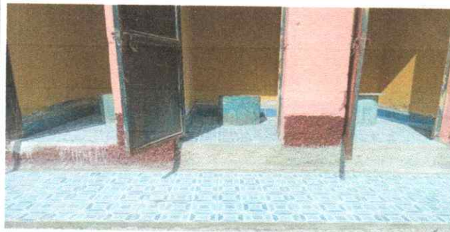
Foto 2: MEJORAMIENTO DE TORTA DE CEMENTO Y PAREDES DE BAÑOS POR AZULEJOS
