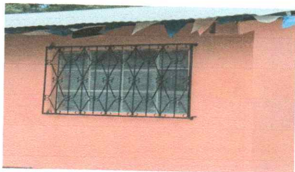
Foto 9: SUSTITUCIÓN DE VIDRIOS DE VENTANA
