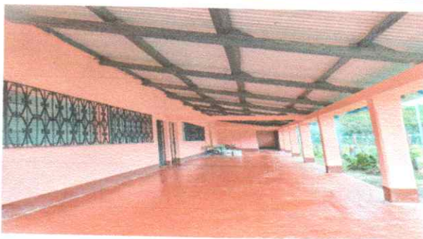
Foto 3: SUSTITUCIÓN DE PISO EN MAL ESTADO DE AULAS Y CORREDOR POR PISO NUEVO.
