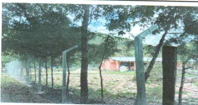
Foto 5: SUSTITUCIÓN DE POSTES DE MADERA POR TUBOS ESTRUCTURA Y ALAMBRES DE CERCO DE PUA POR MALLA PARA CERCO
