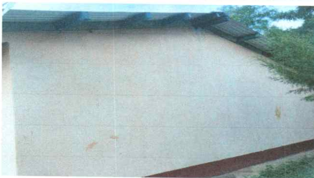
Foto7: SUSTITUCIÓN DE PINTURA INTERIOR Y EXTERIOR
