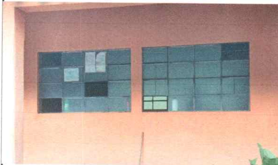
Foto 8: MEJORAMIENTO DE BALCONES
