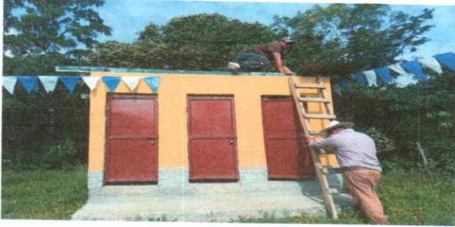
Foto1:SUSTITUCIÓN DE LÁMINA EN MAL ESTADO POR LAMINA TROQUELADA
