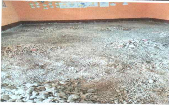
Foto 3:SUSTITUCIÓN DE PISO EN MAL ESTADO DE AULAS Y CORREDOR POR UN NUEVO PISO
