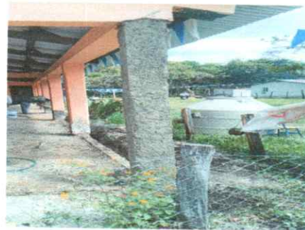
Foto 6: REPARACIÓN DE COLUMNAS DESPELTRADAS
