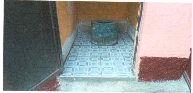
Foto 2: MEJORAMIENTO DE TORTA DE CEMENTO Y PAREDES DE BAÑOS POR AZULEJOS
