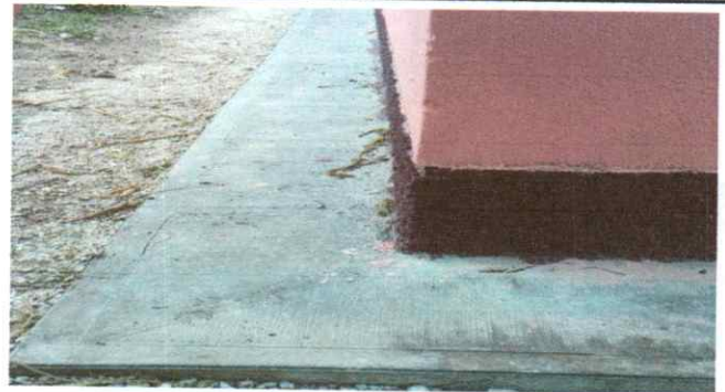
FOTO 4: SUSTITUCIÓN DE BANQUETAS AGRIETADAS POR UNA BANQUETA NUEVA.
