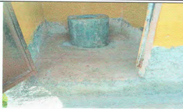
Foto 2: MEJORAMIENTO DE TORTA DE CEMENTO Y PAREDES DE BAÑOS
