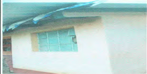
Foto 8: VENTANAS SIN BALCONES.
