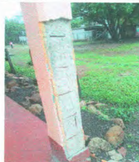
Foto 6: COLUMNAS DESPELTRADAS
