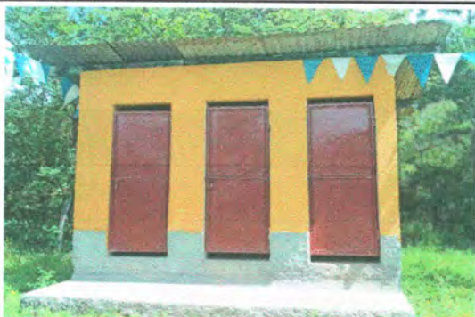
Foto1: SUSTITUCIÓN DE LÁMINA
