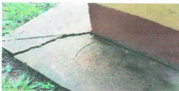
FOTO 4: BANQUETAS AGRIETADAS
