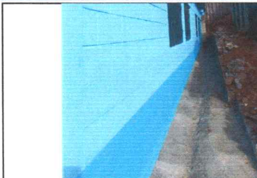
Foto 2: Reparación de cuneta de concreto en mal estado. La cuneta fue modificada a totalidad para que el agua que cae en esa superficie pueda tener salida y no afecte las paredes de la escuela.
