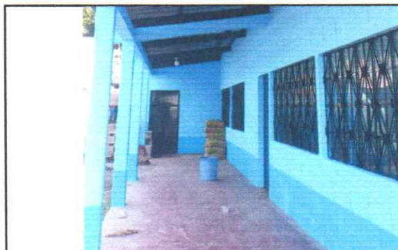
Foto 4: Pintura de paredes exteriores e interiores de las aulas. Las paredes de las aulas fueron pintadas en su interior y exterior, esto permite lograr un ambiente agradable para los niños y niñas.
