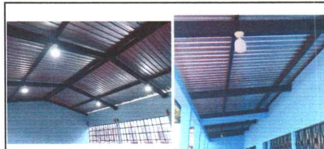
Foto 6: Remozar el sistema Eléctrico de las aulas en su interior y exterior, se realizó el trabajo dentro y fuera de las aulas, esto permitirá una mejor iluminación y ambiente para los estudiantes.
