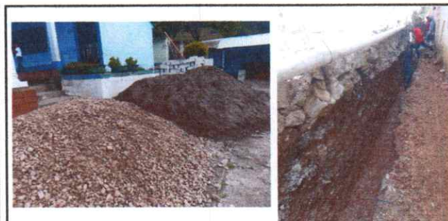
Foto 5: Reparación de muro perimetral de block, se compró el material necesario y tiró el muro que se encontraba en mal estado para dar inicio con el saneado respectivo.
