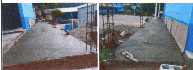
Foto 3: Reparación de banqueta de concreto en proceso.
