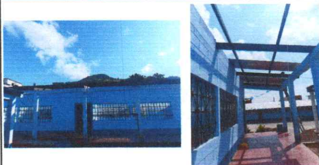
Foto1: El techo de las aulas fue desmontado, luego se pintaron las costaneras para colocar la lámina nueva.
