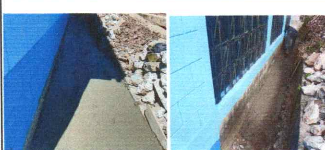
Foto 2: Reparación de cuneta de concreto en mal estado en proceso.
