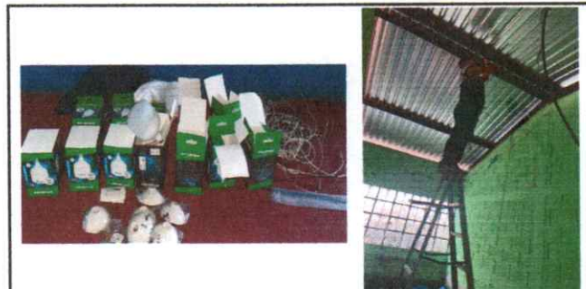
Foto 6: Remozar el sistema Eléctrico de las aulas en su interior y exterior, se inició con la compra del material para realizar el sistema eléctrico.
