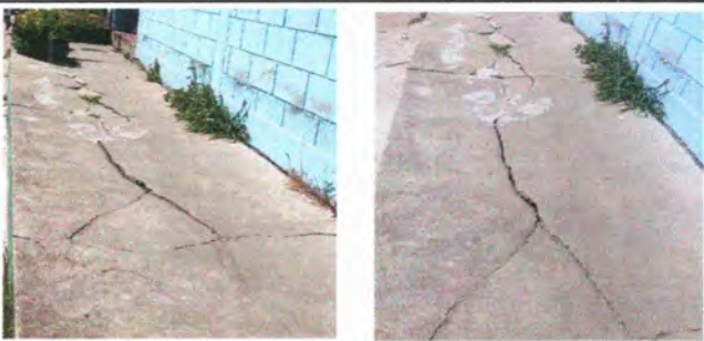
Foto 3: Reparación de banqueta de concreto debido a su mal estado se tiene contemplado reconstruir el paso peatonal entre las aulas.
