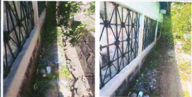
Foto 2: Reparación de cuneta de concreto en mal estado, se tiene contemplado reestructurar para evitar la filtración de agua en las aulas de la escuela.
