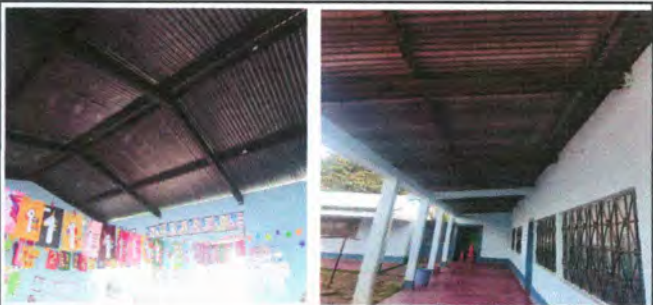
Foto 6: Remozar el sistema Eléctrico de las aulas en su interior y exterior, para mejorar la iluminación del edificio escolar.
