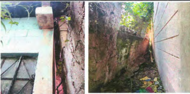
Foto 5: Reparación de muro perimetral de block, se desplomó afectando las paredes de las aulas de la escuela, por lo que se tiene contemplado restaurarlo para que ya no siga dañando las paredes.
