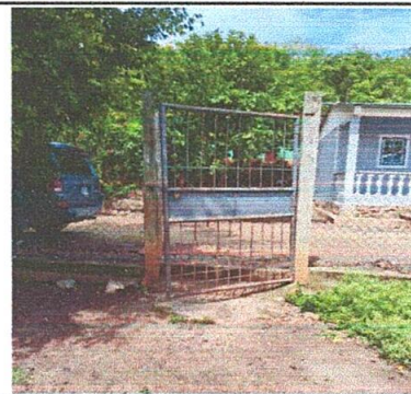
Foto 4: Sustitución de portón de metal
