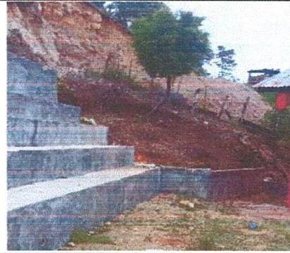
Foto 2: Reparación de muro de contención
