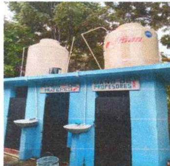
Foto 8: REPARACIÓN Y MANTENIMIENTO DE SISTENA/ DEPÓSITO DE AGUA
