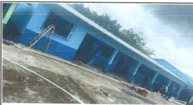
Foto 9: MANO DE OBRA ESPECIALIZADA
