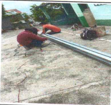
Foto 9: MANO DE OBRA ESPECIALIZADA
