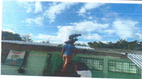
Foto1: Cubierta de Lámina
