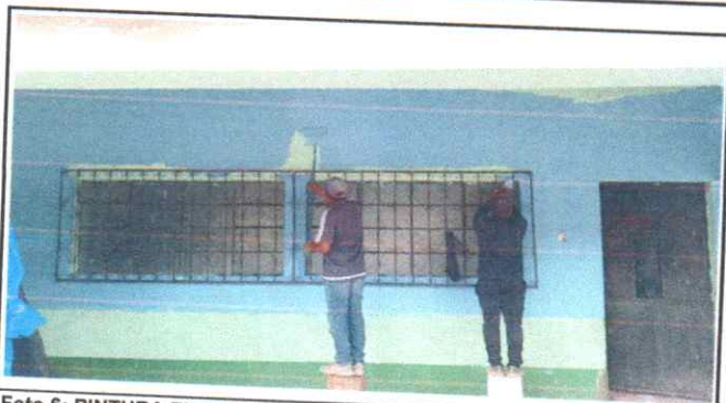
Foto 6: PINTURA EN MUROS INTERIORES Y EXTERIORES
